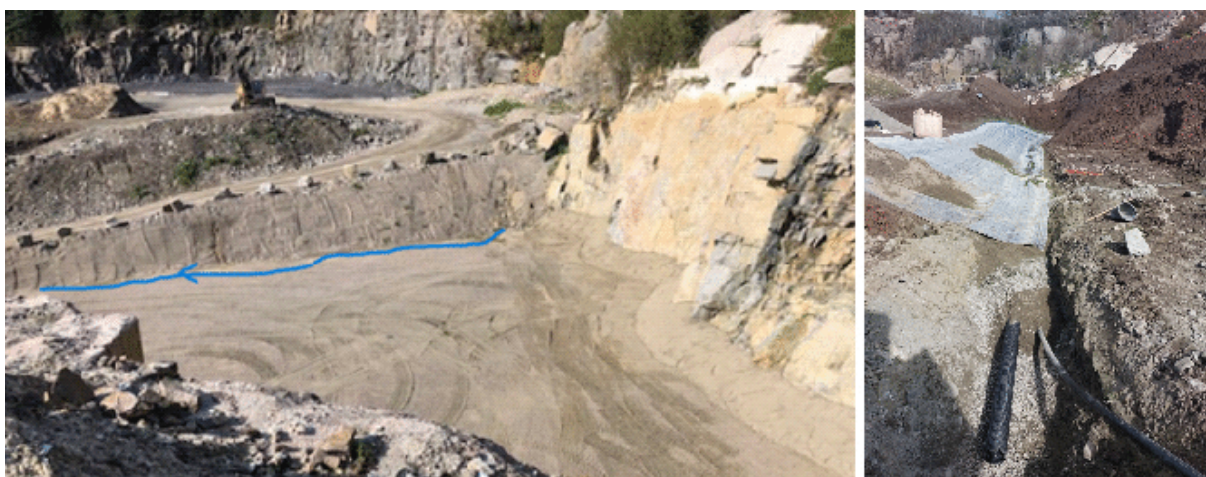
Figur 2 Drenering av PFAS cellen er lagt i en grøft langs med veiskråningen (Foto fra MAREN).
