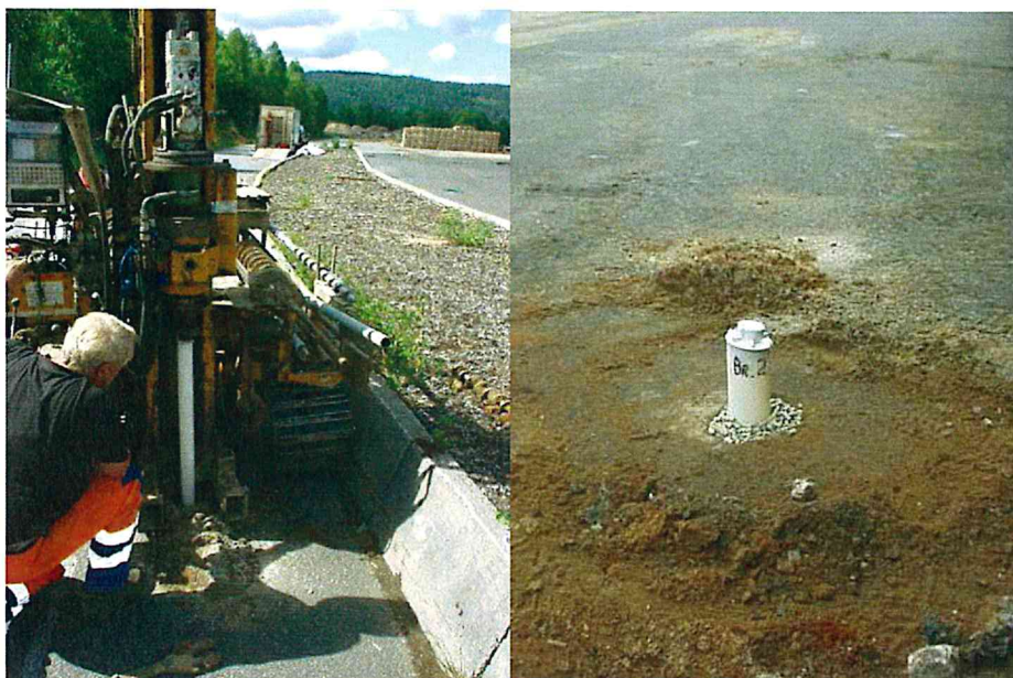
Figur 5: Bildet til venstre viser hvordan en miljøbrønn blir dunket ned i hullet som var boret med skovelbor. Bilde til høyre viser ferdig brønn tett med bentonitt, og påsatt låsbart lokk.
