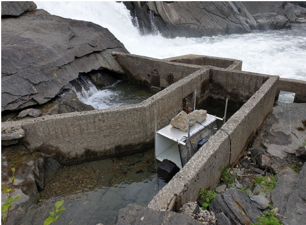
Bilde: Plassering av videotunellen i fisketrappa i Drevja. I forkant av videotunellen er det montert et ledegerde slik at fisken ikke kan passere utenom. Fisketrappa i Drevja. Fotograf: Aslak Darre Sjørusen
