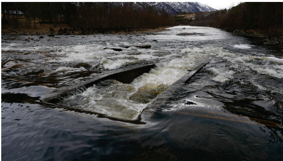
Figur 27. Trappa i Stibergterskelen. Tverrliggeren i toppen gjør at vannstanden synker mye straks vannføringa blir mindre enn slukeevna i spalta. Ved å snevne inn åpninga med nålestengsel vinterstid, kan vannstanden holdes høgere til fordel for gytegroper i øvre enden av terskelbassenget. Foto: Karl Øystein Gjelland
