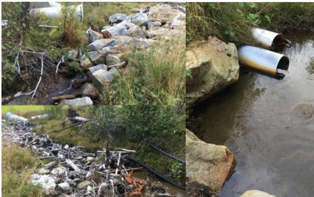
Figur 49. Bekkeløpet mellom stasjon S12 og S13 er gjenfylt med røtter, blokk og storstein, vassdraget er i tillegg lagt i rør (til venstre) over en strekning på 15-20 bekkemeter. Dette gir svært vanskelig vandringsvei for den lokale ørretbestanden, som tidligere har benyttet ovenforliggende gyteområder.
