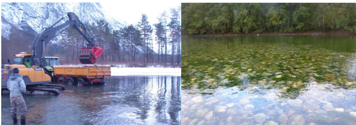
Bildeserie 9. Et mulig vedlikeholdstiltak i tiltaksområdet i Røssåga er fjerning av finsedimenter med sorteringsskuffe etter samme modell som i Eira. Foto: Nils Arne Hvidsten (venstre bilde) og Jan Gunnar Jensås (høyre bilde).
