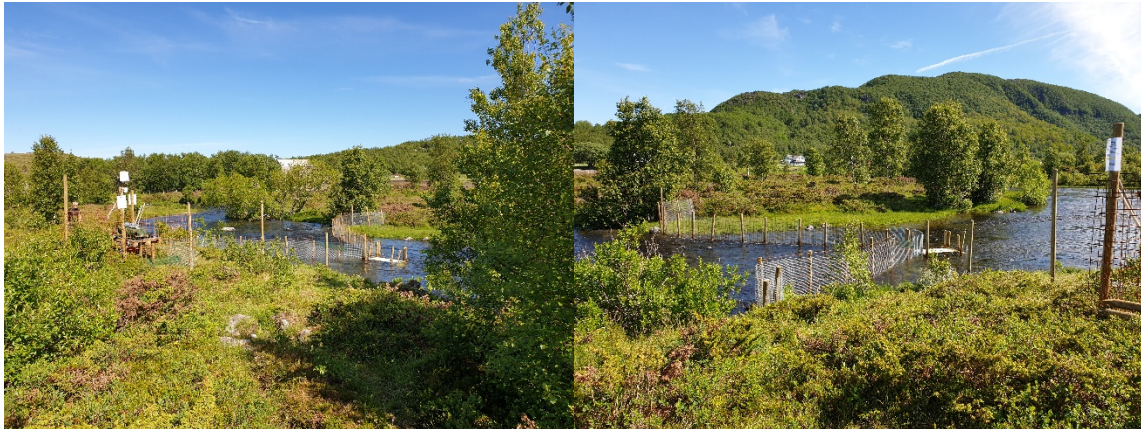
Bilde: Ledegjerde og videotunnel i Fjæreelva 2019.
