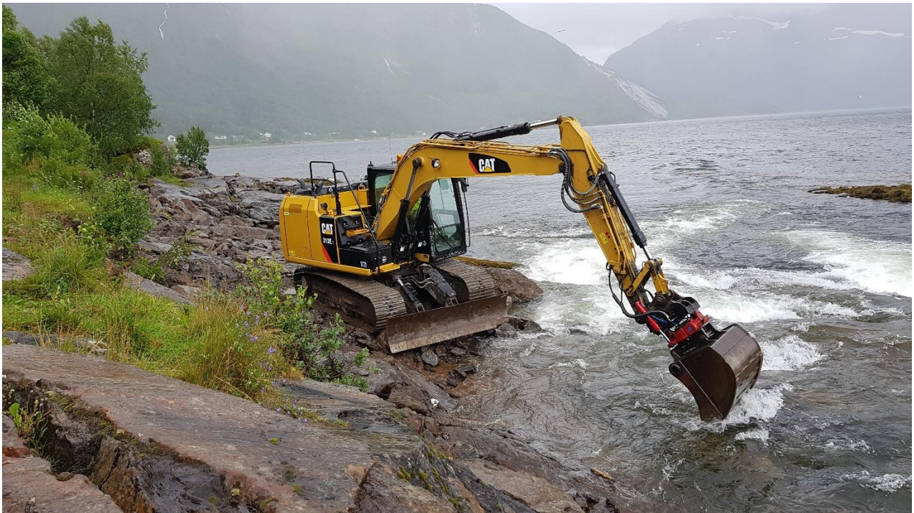
Bildet 1. Viser gravemaskin under arbeid med fjerning av tidligere utlagt steinfylling langs elvebredden. Vannføring ca. 8\text{m}^3/\text{sek} på tidspunktet.
