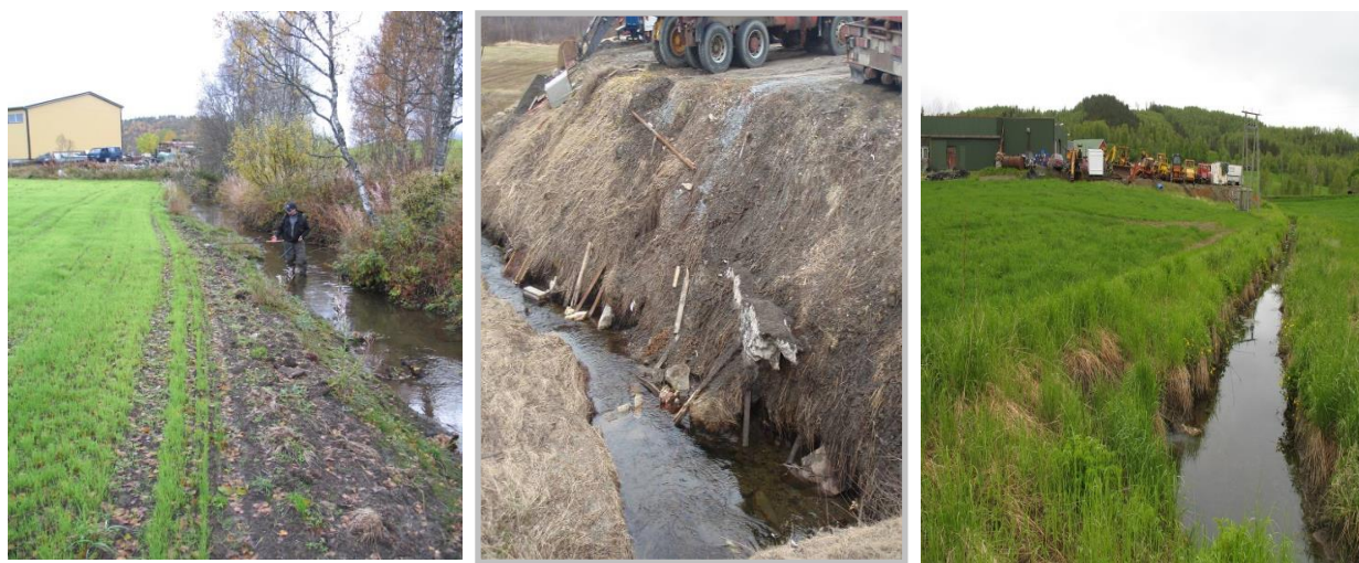
Figur 37. Saurakitta. Fra venstre øvre strekning, i midten ved maskinverksted og til høyre strekningen nedstrøms vei. Bekken er kanalisert på lange strekninger, det er dyrket helt ut til bekkekanten og kantskog mangler helt på lange strekninger.
