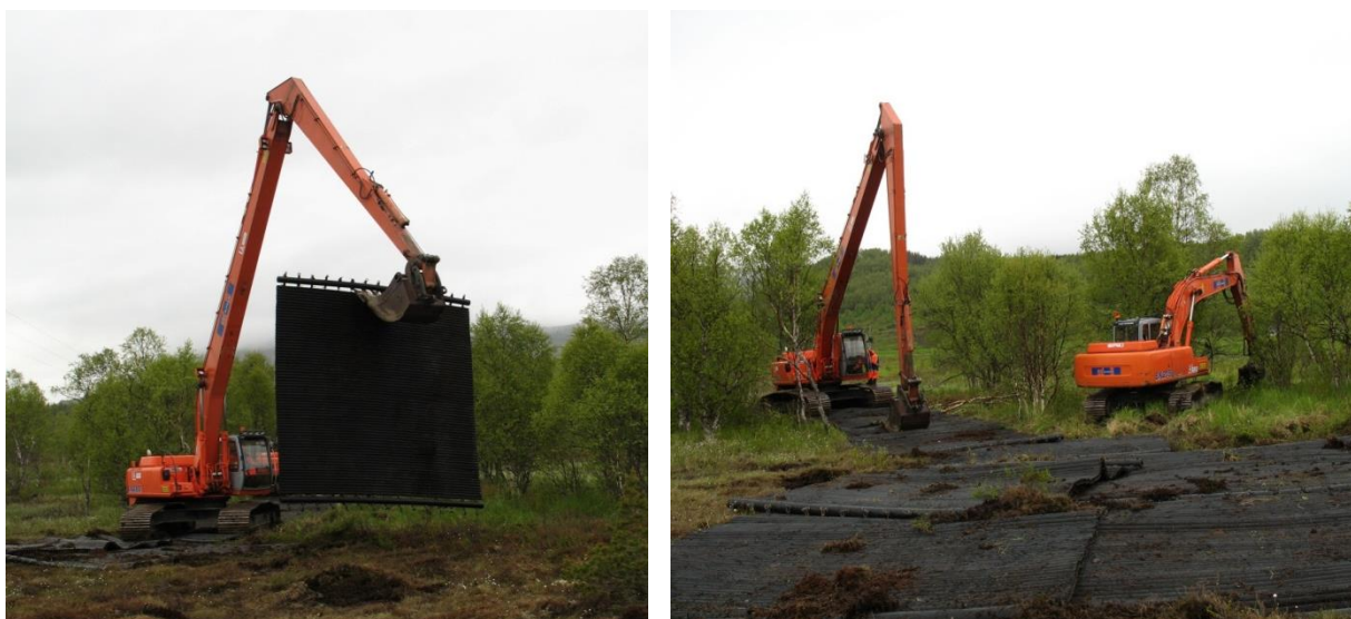
Figur 38. Til gravearbeidene ble det benyttet en maskin med spesielt lang arm og det ble benyttet spesialmatter for å lage kjørevei gjennom terrenget og som underlag ved selve gravearbeidet for å unngå å sette spor i terrenget.
