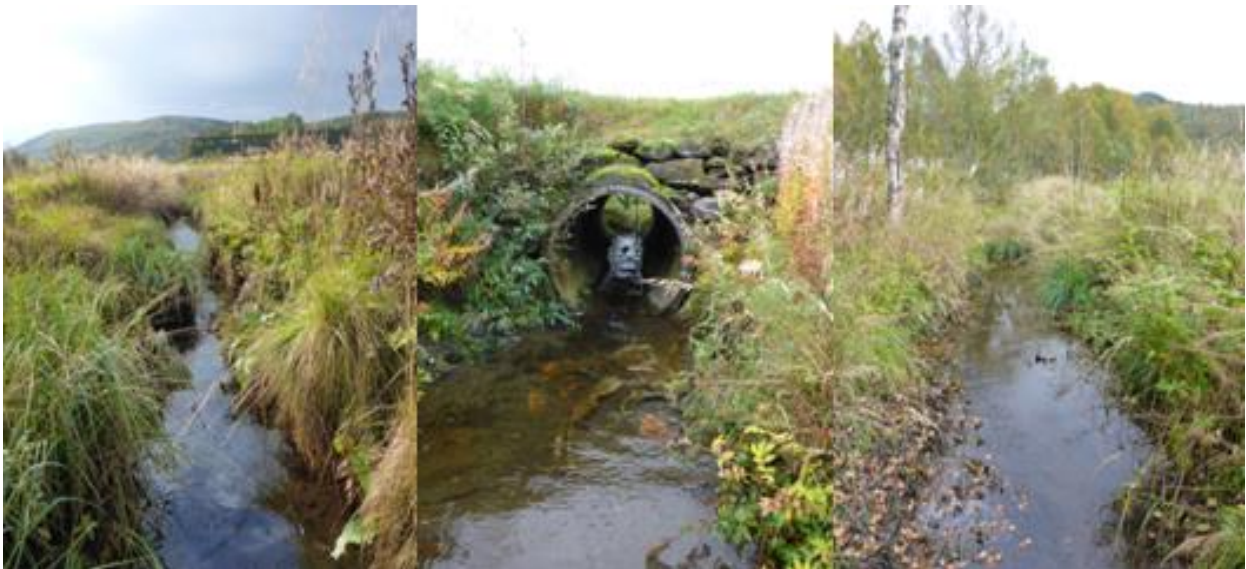
Figur 15. Saurakitta. Foto til venstre viser nedstrøms vei med overhengende torvkanter og høyt gress inntil bekken. For fiskevandring er kulverten under veien ok (midtre foto). Foto til høyre viser at bekken er kanalisert også oppstrøms veibro/verksted. Avrenning fra landbruk og verksedsvirksomhet påvirker vannkvaliteten. Bekken var i 2014 fisketom.
