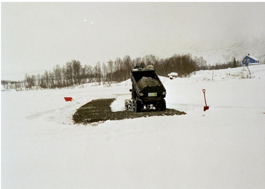
Figur B4. Prøvefelt. Foto fra arbeid på isen vinteren 2002 i forb. med tildekking av vegetasjonen ved bruk av geotekstil og pukk i elvesnelle beltet nedstrøms Djupvika.
