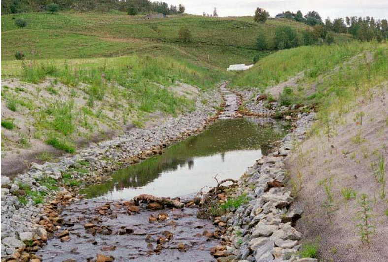
Figur 34. Jordbrukskanalen fra Brukåsmoen. Foto tatt like etter at ravinen vist i figur 1 er rehabilitert.
