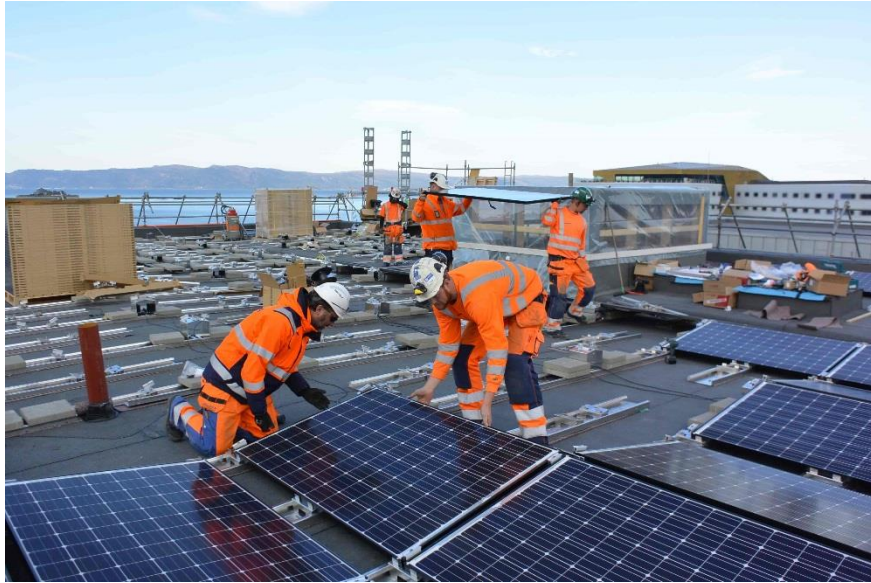
Skanska monterer solceller på taket på BI-bygget, Brattørkaia, 28.09.2017
