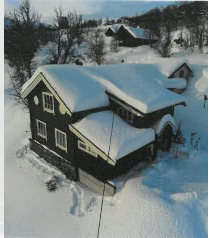
Foto: Bildet er hentet fra befaringsrapport 21.03.2025
