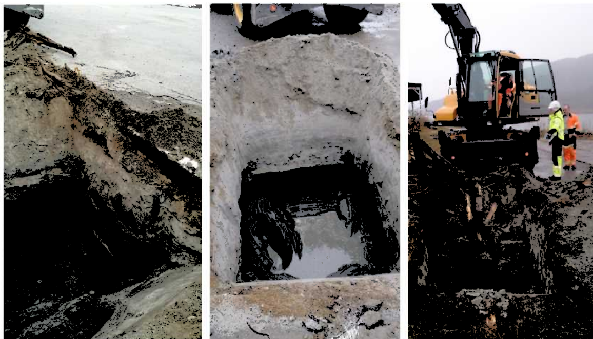
Figur 5 Eksempler av observerte sjikt på eiendommen. Sjakt M12 (på mudringsmassenes topp sees jernbanesville under asfalt), venstre. Sjakt M24 (mudringsmasser med innsig av grunnvann), midten. Profil M28 (mudringsmasser med jernbanesviller), høyre.
