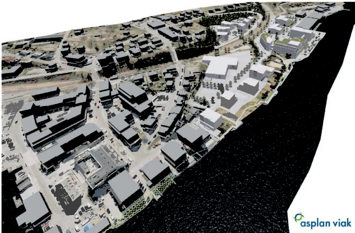
Figur 44: Strukturen langs Strandgata bygger videre på dagens struktur. Boligområdet på Troa er etter høring tatt ut av planen.
