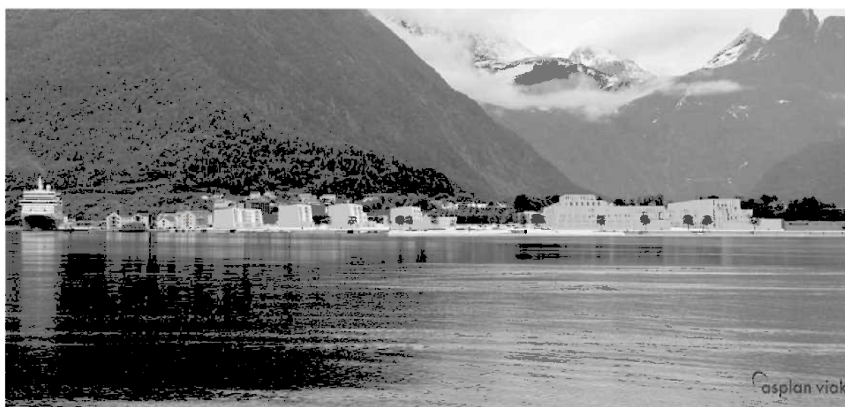
Figur 28: Åndalsnes med ny bebyggelse sett fra sjøen.
