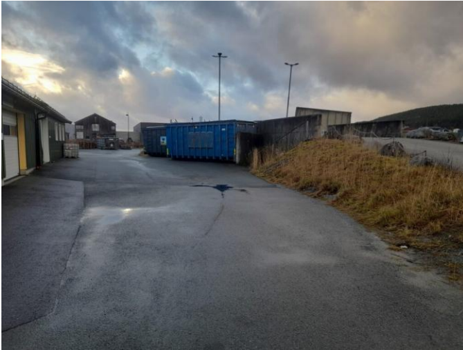
Containere ved rampe
