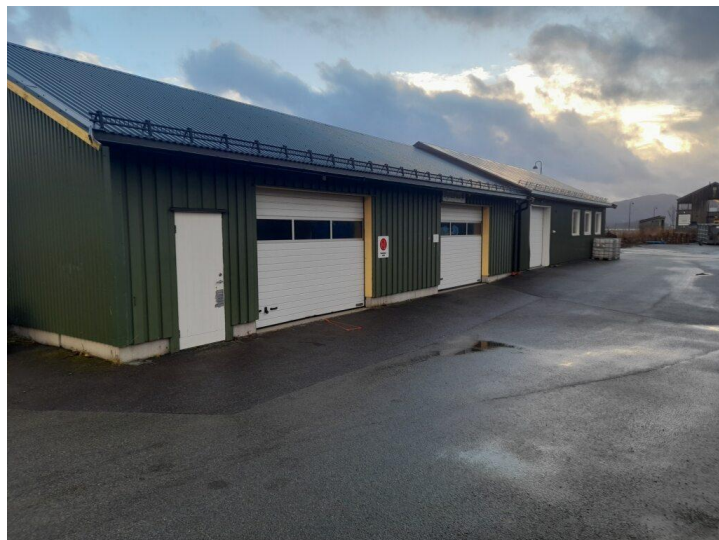
Lagerbygg for farlig avfall, byttebu etc
