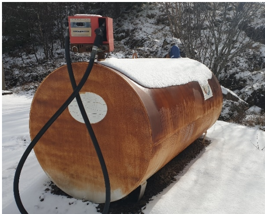
Figur 2. Lagertank for diesel. (Foto: Statsforvalteren)
