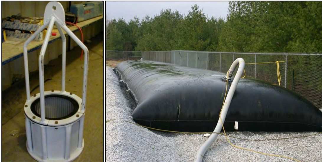
Figur A1. Ved å lede anleggsvannet gjennom en sil eller siltpose vil man effektivt samle opp plastpartikler før vannet slippes til resipient. Bildet av siltposen er hentet fra scorpioncontaminant.com.
