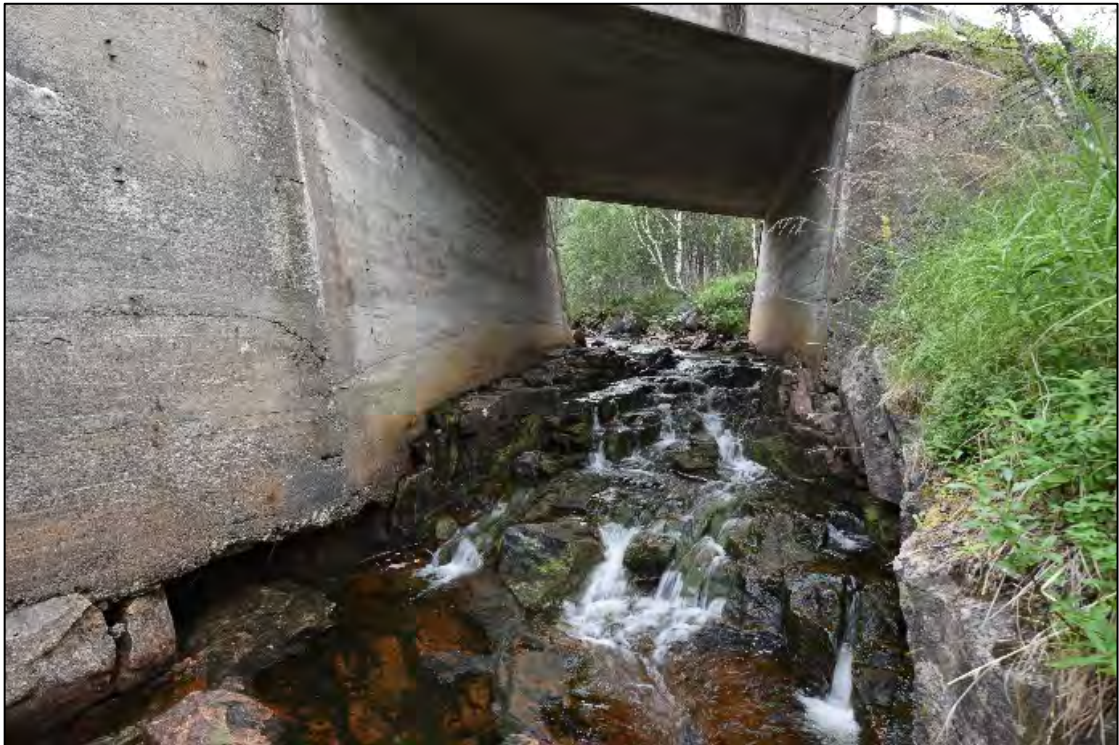
Figur 5.2.4 Det er behov for utbedring av oppvandringsmulighetene til fisk under broa som krysser Austerdalselva. Foto: Geir Arnesen.
