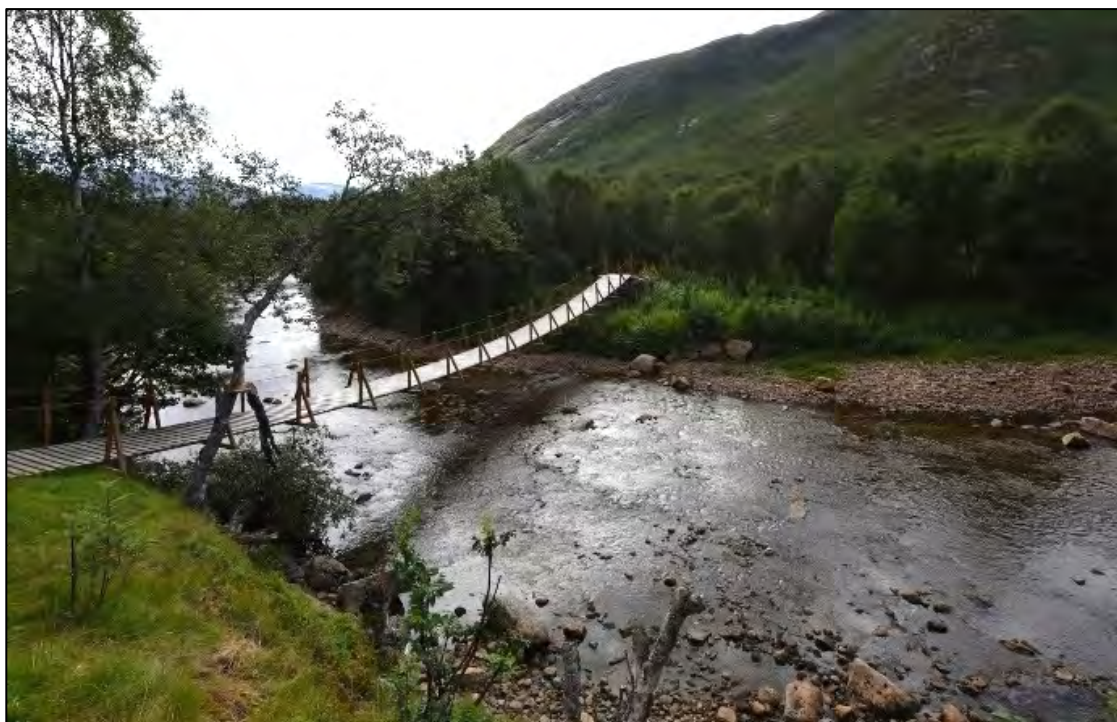
Figur 5.5.2 Kongsvikelva der riggområde og krysningspunkt under anleggsperioden planlegges. Foto: Geir Arnesen
