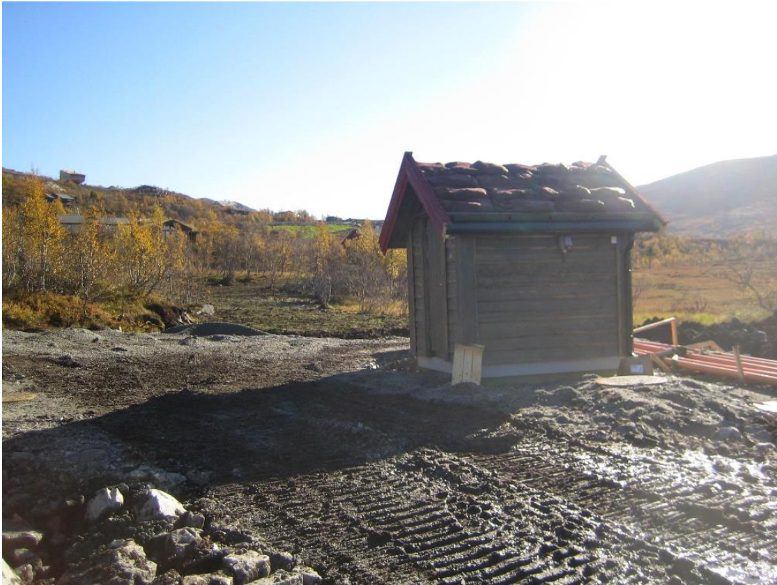
Figur 4 P5 Tverrli pumpe­stasjon etter bygging. Pumpe­stasjonen er en typisk/standard pumpe­stasjon med overløpstank i Sysendalen.
