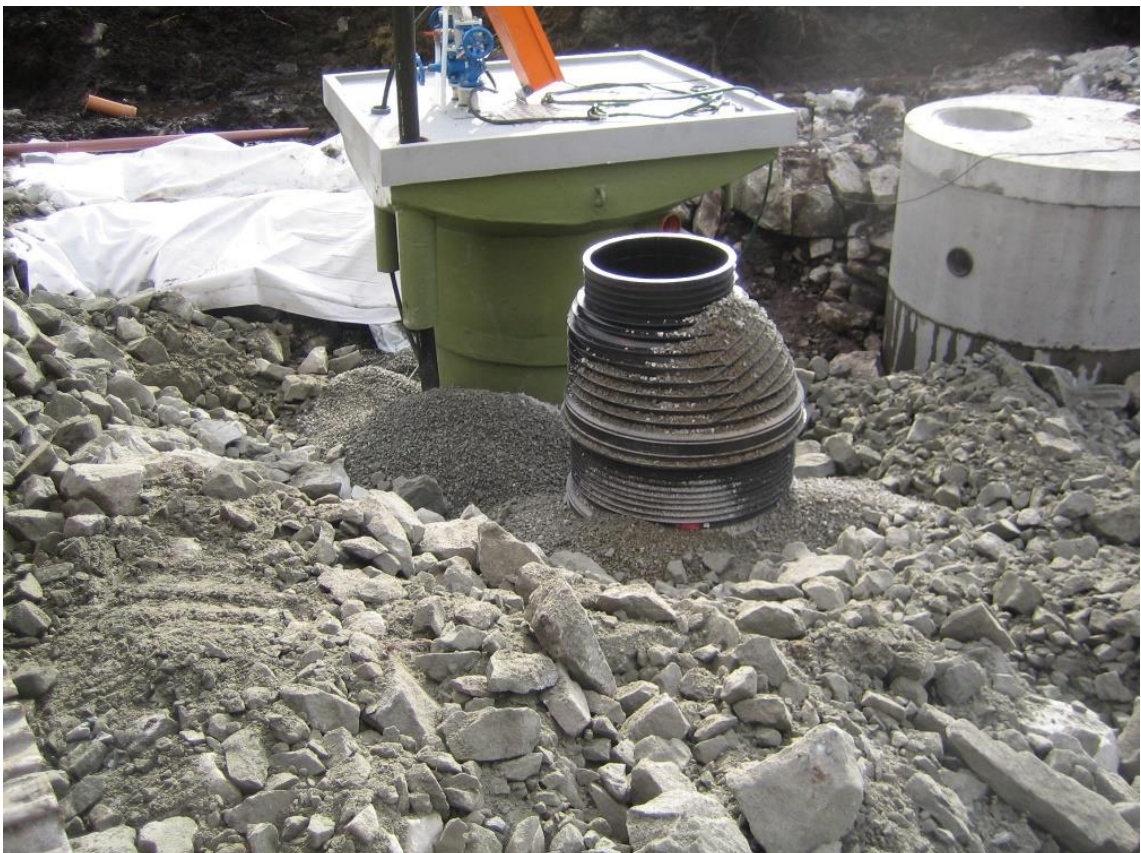
Figur 3 P5 Tverrli pumpestasjon under bygging. Pumpestasjonen er en typisk/standard pumpestasjon med overløpstank i Sysendalen.
