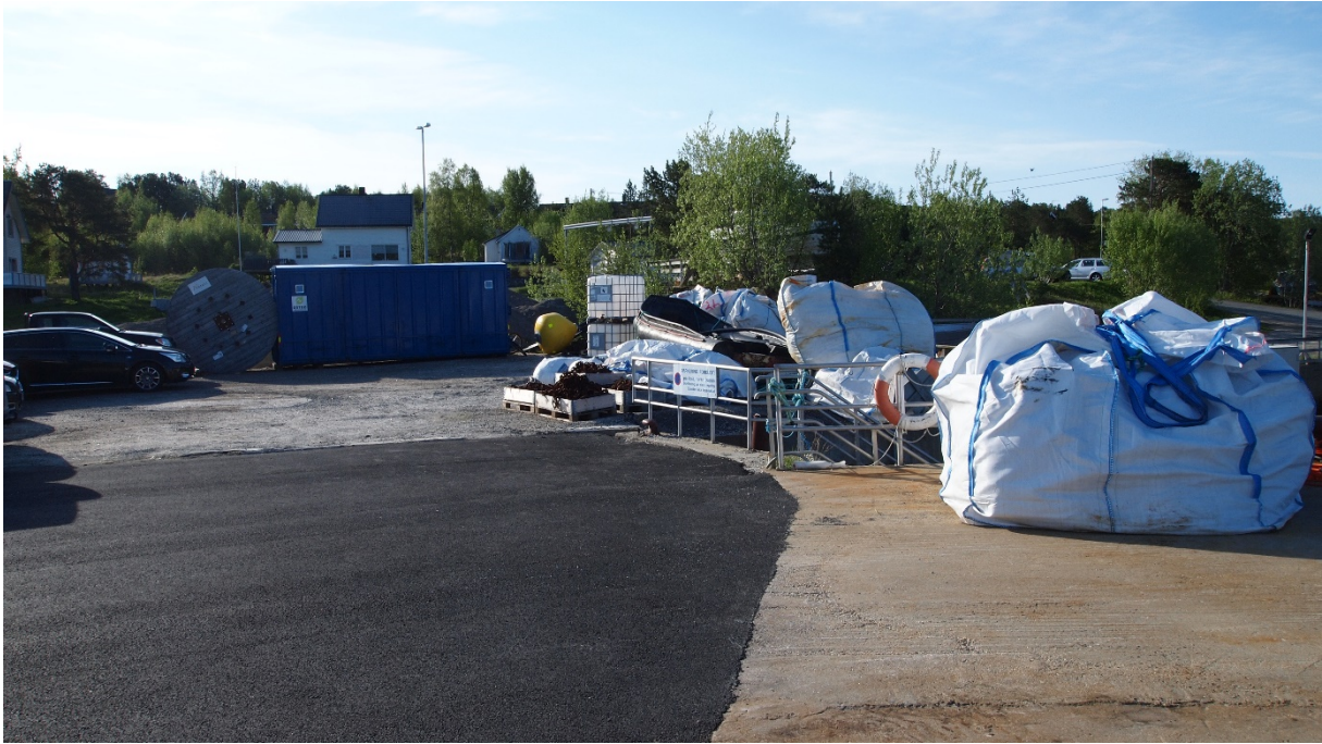
Bilde 1. Kaianlegg ved Ellingsen Seafood As sin landbase.
