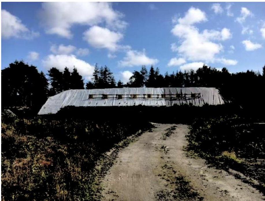
Figur 2-4. Overdekket kulefangvoll for 300 meters banen med skivevoll i forkant. Kilde: bildet er hentet fra COWI-rapport, 2020 (Fjell skytebane, Våler kommune, Miljøtekniske grunnundersøkelser og tiltaksplan, REF 1).
