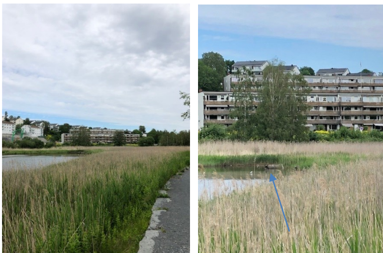
Figur 9 Utløpet av overvannsledning OV600 (nødoverløp for spillvann) innerst i Holtekilen. Utløpet er markert med oransje pil. Bildene er tatt fra kyststien på østsiden.
