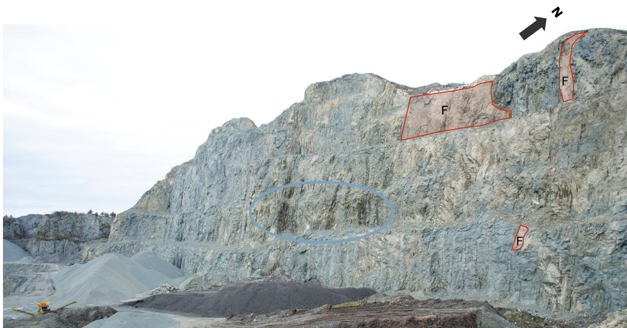
Figur 13: Bruddvegg nord sett mot vestre hjørne. Mindre soner med vann midt i bruddveggen som kommer fra terrenget over.
