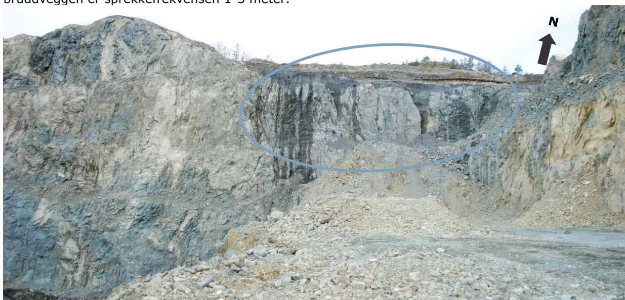
Figur 12: Bruddvegg nord i nordlig hjørne. Tydelig observasjon av vann langs sprekkkeplan som har avrenning fra terrenget over.
