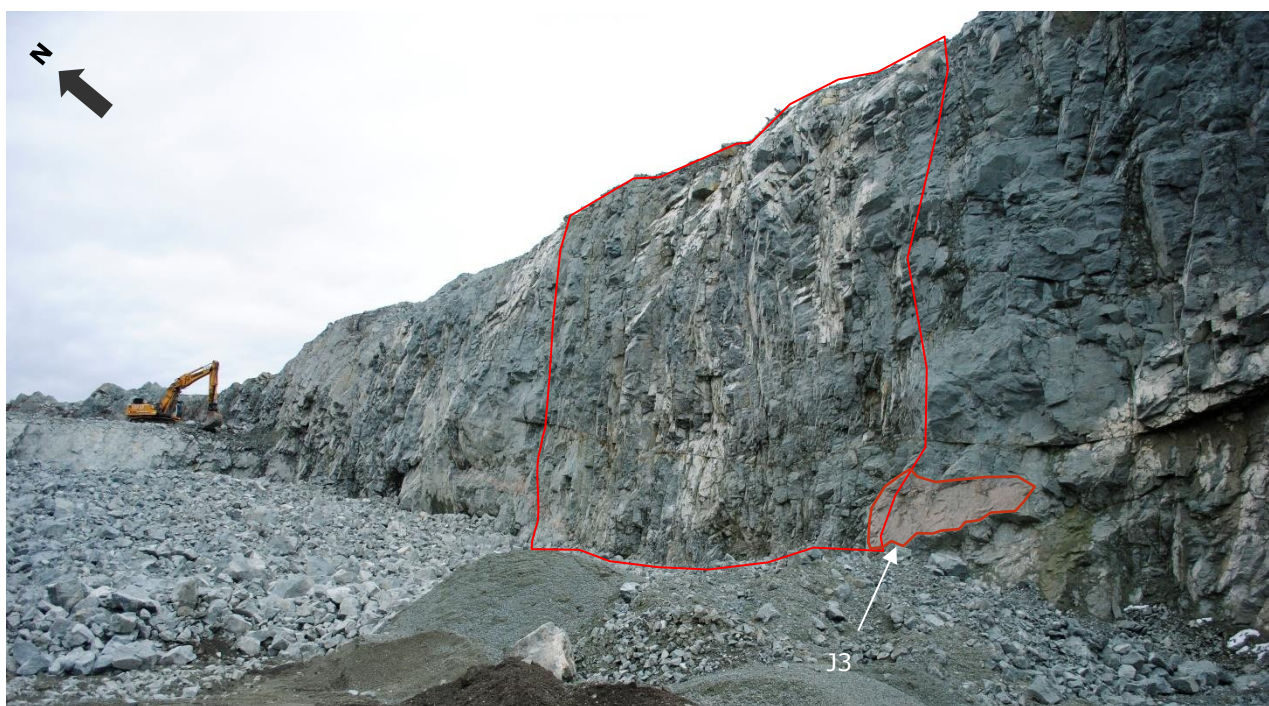
Figur 7: Bruddveggen mot sørøst på kote +5. Tydelig knusningssone er markert med rødt areal. Skravert område viser J3.
