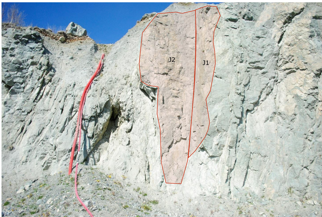
Figur 14: Bruddvegg nord i vestre hjørne. Sprekkesett J1 og J2 blir mer gjennomsettende og danner kileutglidning.
