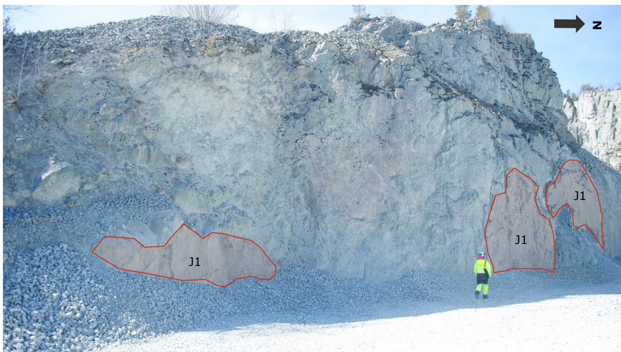
Figur 16: Bruddvegg vest i sørlige del. Sprekkeseett J1 er parallell med og faller inn i vegg, som gir et svakt overheng med lite løse blokker.
