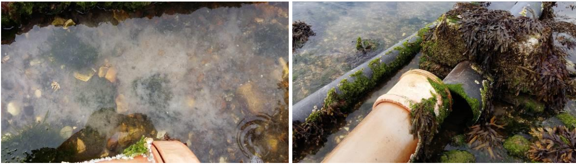
Figur 16. Stasjon L2, Tomasjord 2016. Utslipp fra et skadet kloakkrør. Dopapir og slimete trådformede grønn- og brunalger.- Sewage pipe damage. Right: Toilet paper and filamentous green and brown algae
