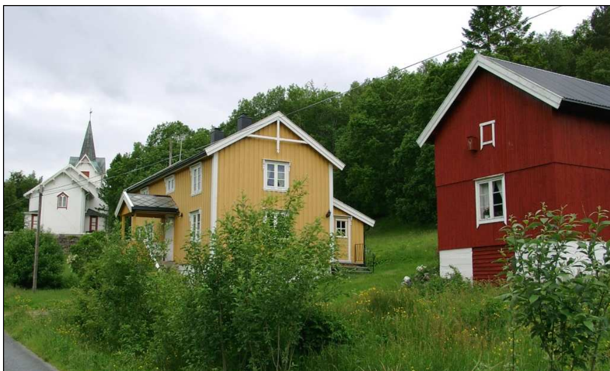
Figur 4. Kirka og smågårdsbebyggelsen på Heimsjøen utgjør et attraktivt kulturmiljø.
