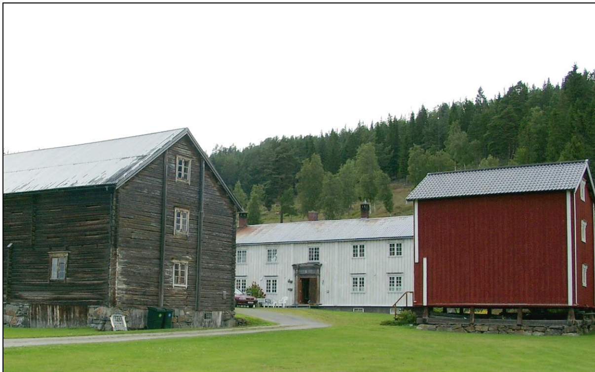
Figur 17. Søstuggu Midttømme er et typisk trøndertun og et velholdt bygningsmiljø med noen av de eldste bygningene i området.
