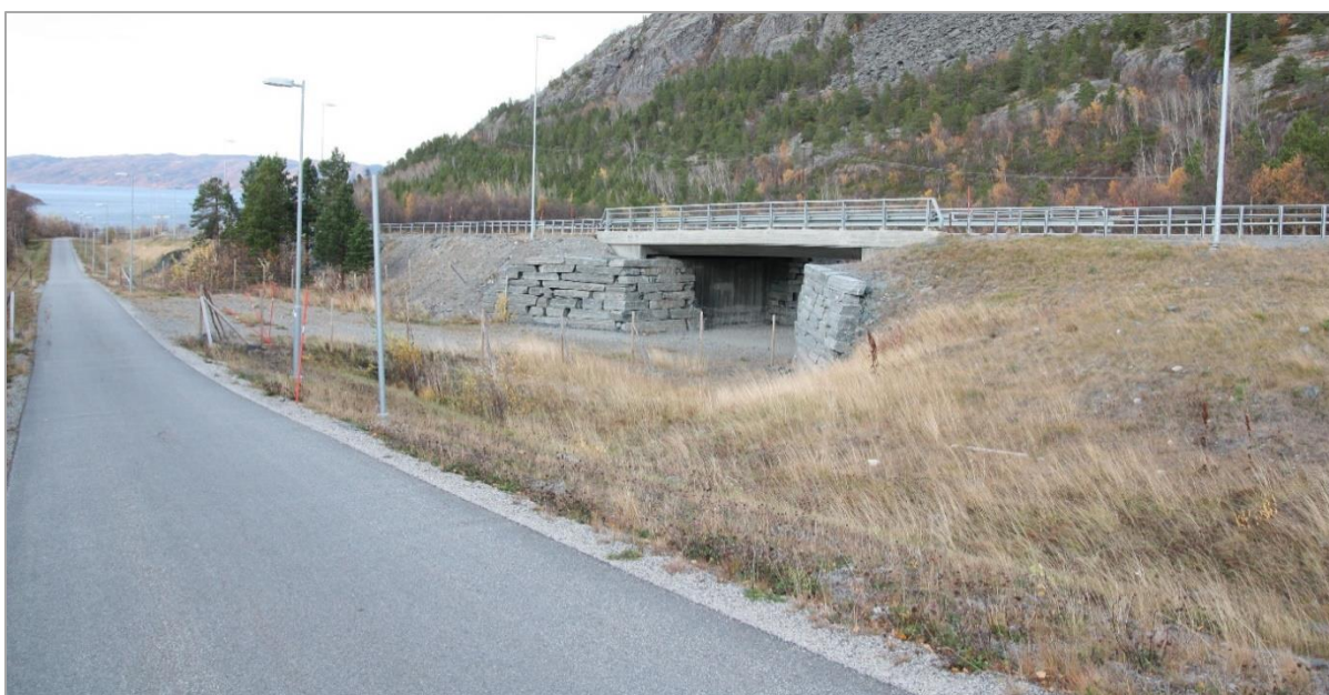
Figur 6-24. Gang- og sykkelveg vest for og parallelt med E6. (Foto: Mildrid Elvik Svoen/Sweco Norge AS)
