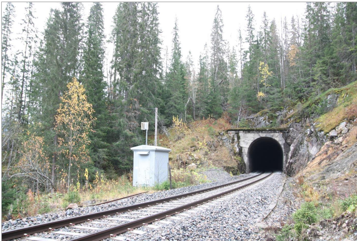
Figur 6-26. Tunneltakene på Nordlandsbanen har en viktig rolle for å sikre behovet for flytt- og trekkleier for rein og annet hjortevilt på strekningen hvor det er etablert dobbeltsidige viltgjerder mot påkjørsler i Vefsn og Grane kommune. Foto viser den nordlige inngang til Falkflåget tunnel. (Foto: Mildrid Elvik Svoen/Sweco Norge AS)
