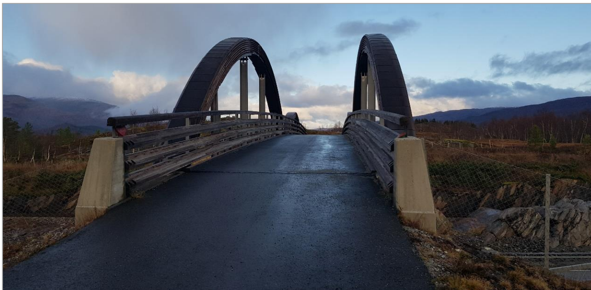
Figur 6-15. Løkåsheia bru sett fra nord. Stigning inn mot midten av brua gjør at reinen ikke ser utgangen av brua når den kommer inn mot passasjen. (Foto: Magne Haukås/Norconsult AS)
