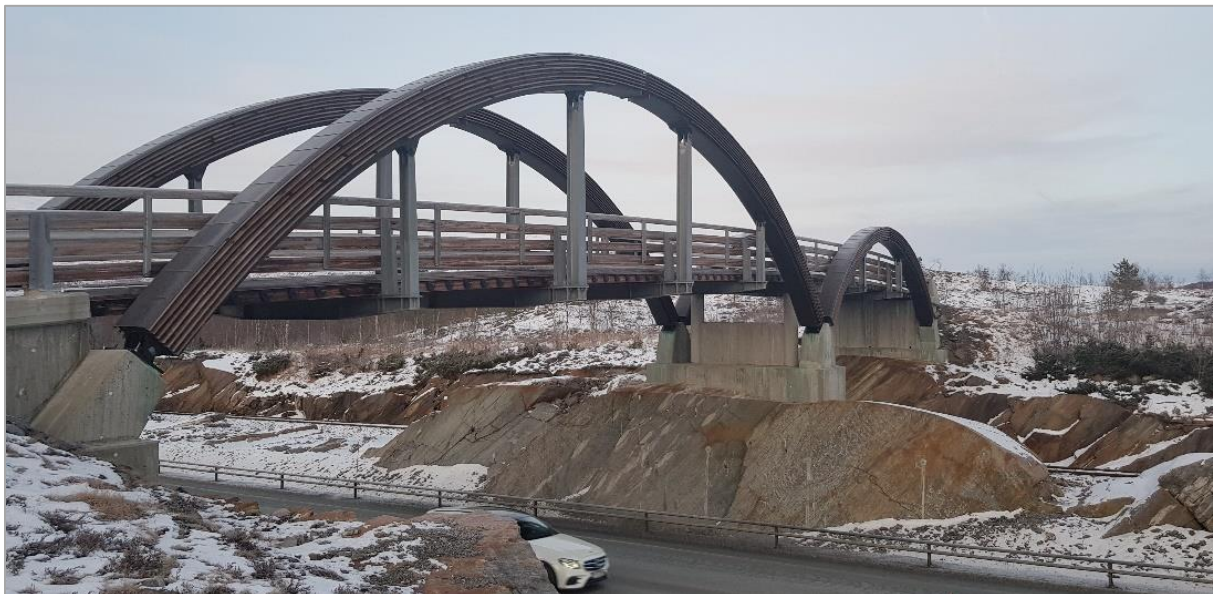
Figur 6-9. Løkåsheia bru sett mot nord. Det største bæreelementet går over Riksveg 80, og det minste går over Nordlandsbanen. (Foto: Magne Haukås/Norconsult AS)
