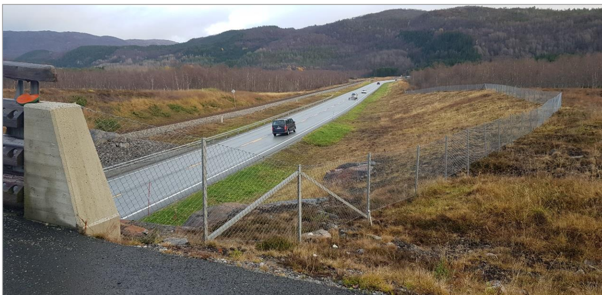
Figur 6-13. Gjerder langs riksveg 80 fra Løkåsheia bru og ca. 150 m østover. (Foto: Magne Haukås/Norconsult AS)
