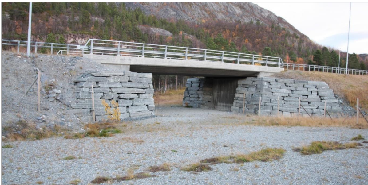
Figur 6-23. Undergangen sett fra nordvest i lengderetningen reinen kommer fra på høsten. Hadde åpningen på undergangen vært skråstilt, ville åpningen opplevdes større. (Foto: Mildrid Elvik Svoen/Sweco Norge AS)
