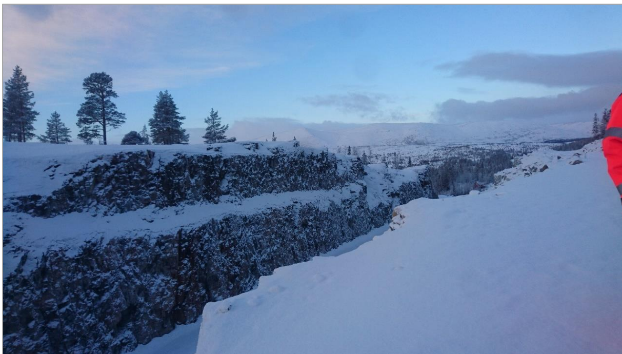
Figur 6-4. Skjæring for ny E6 i traséen for reindriftrasens flyttleia ved Sefrivatnet før overgangen ble bygget. (Foto: Fylkesmannen i Nordland)
