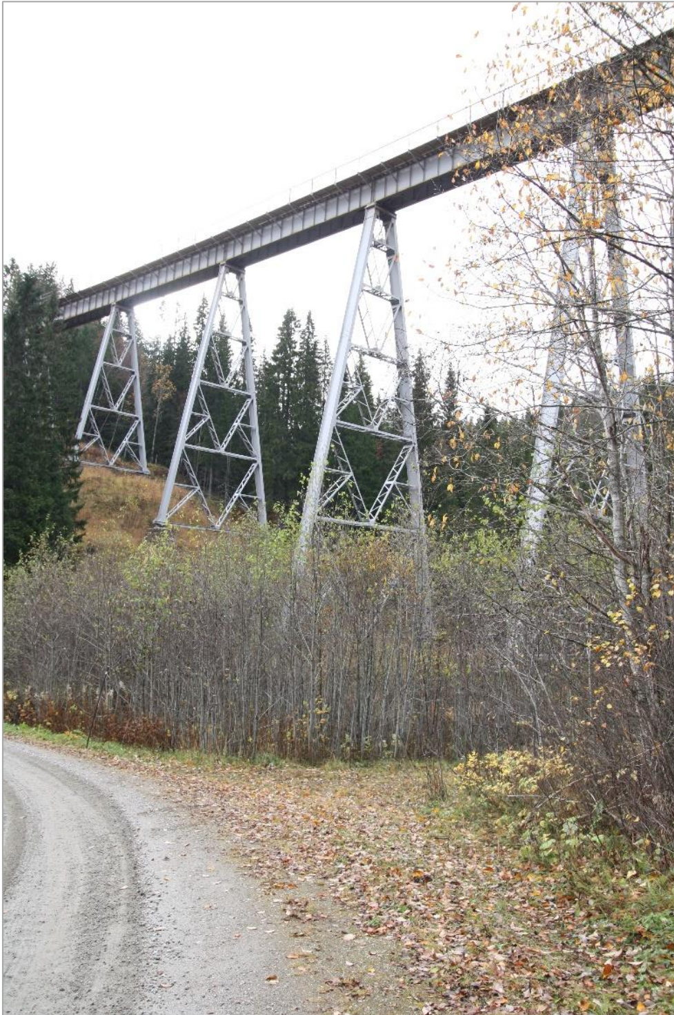
Figur 6-33. Trolldalen viadukt ved Valstad er godt egnet for flytting trekk og av rein når det er stabile isforhold slik at det er trygt å krysse Vefsna. Viadukten har trolig også god funksjon som passasje for annet hjortevilt. (Foto: Mildrid Elvik Svoen/Sweco Norge AS)
