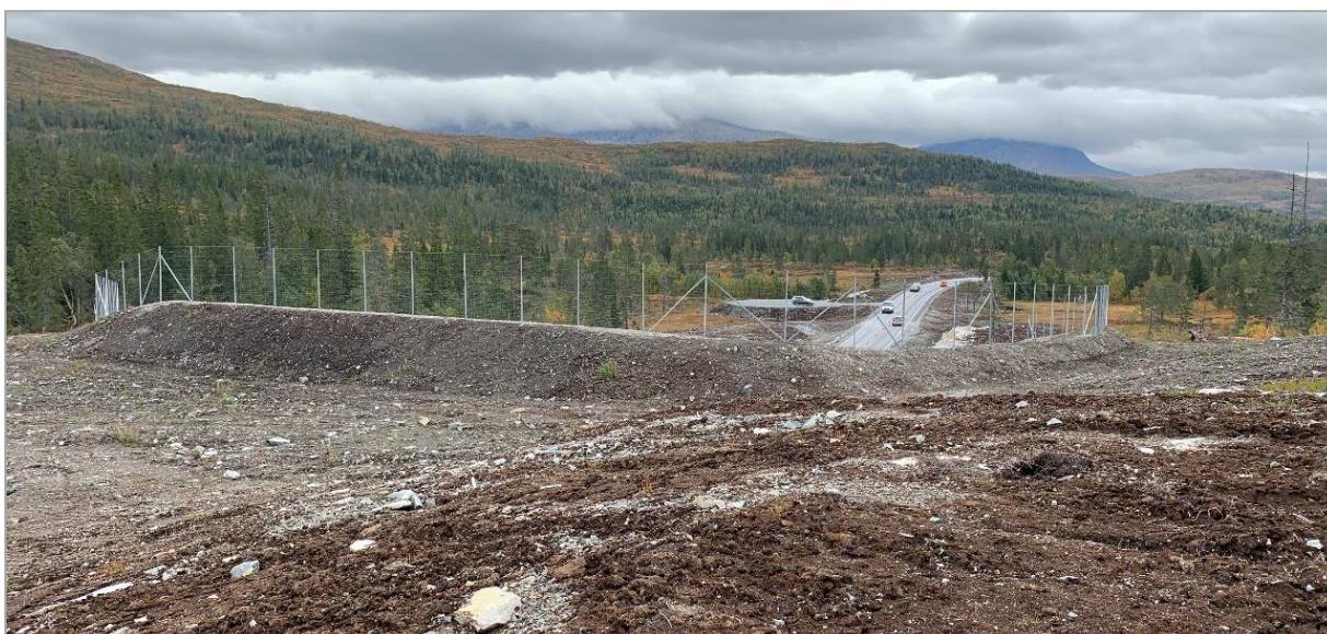
Figur 6-5. Øverst vises passasjen over økoduken sett fra øst. Den tilgjengelige bredden for reinen er ca. 50 m. Nederst vises passasjen sett fra nordvest. Jordvollen er strukket noe sørover for å skjerme mot støv og lysrefleksjoner fra skjæringa, hvor E6 kommer ut under overgangen. På toppen av vollen er det etablert gjerder. Et stykke sørøst for passasjen er det etablert en parkeringsplass for transport av tømmer. (Foto: Rainer Smedseng/Statens vegvesen)
