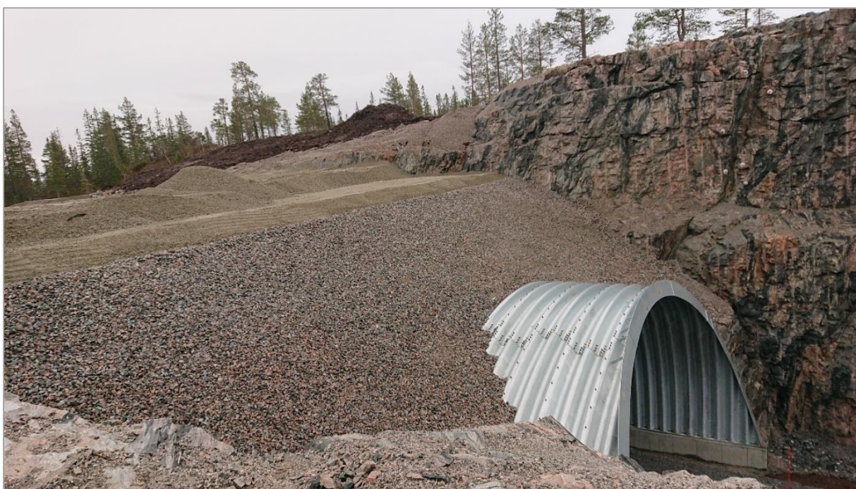
Figur 6-8. Økoduken har frie siktlinjer over passasjen både fra vest (øverst) og øst (nederst), med skog og furukoller som naturlig omslutter passasjen i begge ender. Før ferdigstilling av passasjen ble det gjennomført en befaring mellom Statens vegvesen og reinbeitedistriktet, hvor behov for justeringer av voller og terrengtilpasninger ble avklart. (Foto: Mildrid Elvik Svoen/Sweco Norge AS)
