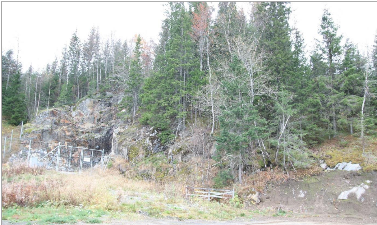
Figur 6-28. Fallan tunnel ved Fallmoen i Grane kommune har tidligere vært brukt til flytting av rein. Her erfarer reinbeitedistriktet at reinen trekker på egenhånd etter at viltgjerdene langs jernbanen ble bygget. Tunnelinngangen fra sør sees til venstre i bildet. (Foto: Mildrid Elvik Svoen/Sweco Norge AS)
