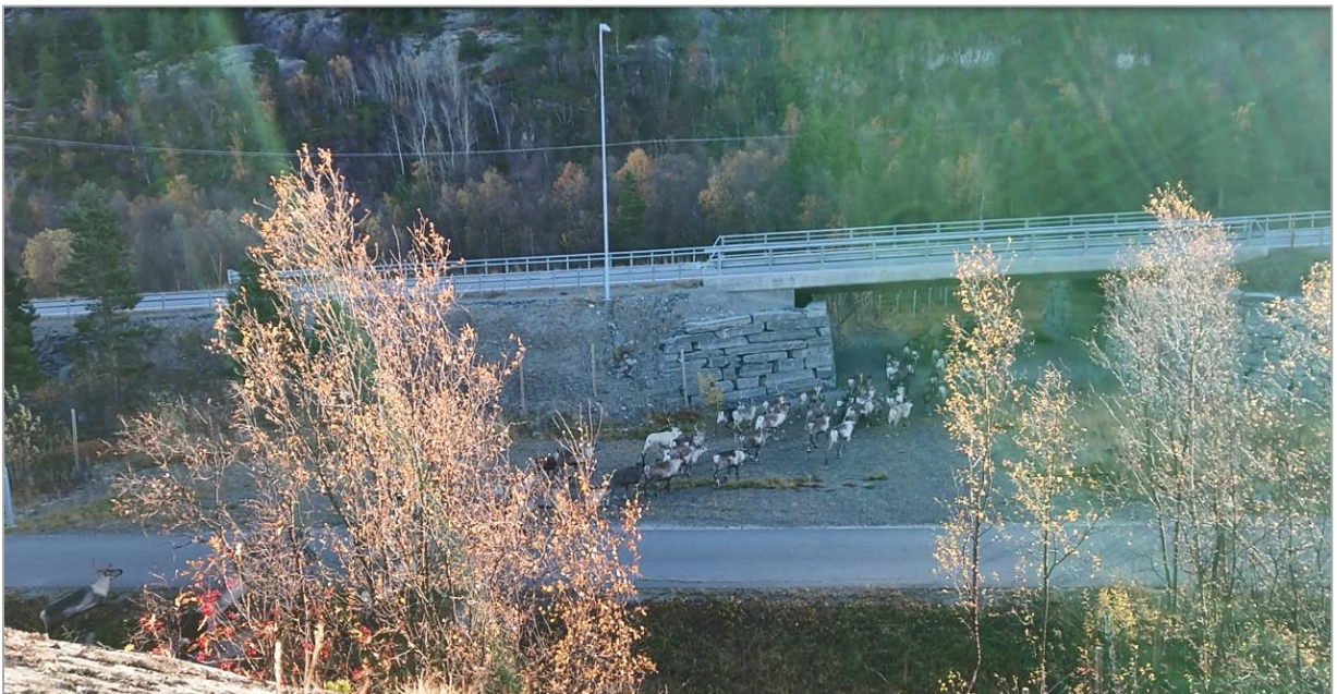
Figur 6-20. Reinen flyttes fra landgangsfartøy gjennom Aslakheimen bru september 2021, og løper greit gjennom undergangen. (Foto: Mildrid Elvik Svoen/Sweco Norge AS)
