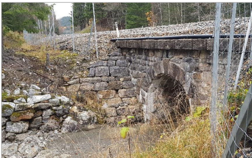
Figur 6-31. Kulvert ved Grasørbekken hvor det er observert reinspor gjennom kulverten under jernbanen. Foto viser også reingjerdene som er satt opp på begge sider langs Nordlandsbanen. (Foto: Magne Haukås/Norconsult AS)
