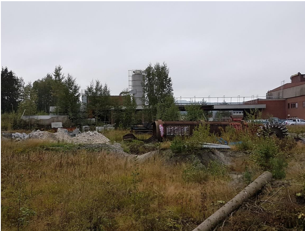
Figur B.5 Gjenvinningsanlegget sett fra gangstien nord for området. Mølla til venstre i bildet.
