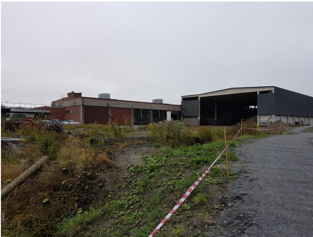
Figur B.6 Gjenvinningsanlegget sett fra gangstien nord for området. Sikteverket til høyre i bildet.
