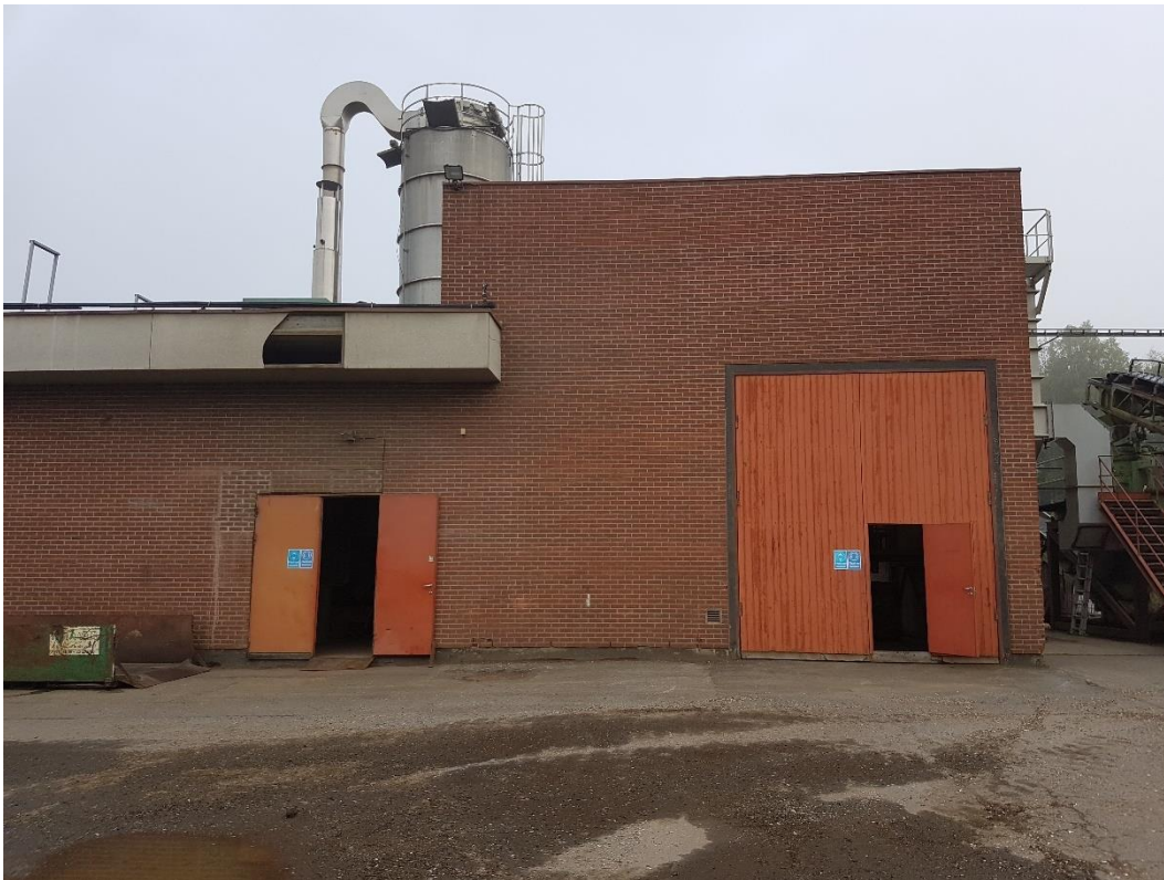
Figur B.1 Møllebygning sett fra sør.
