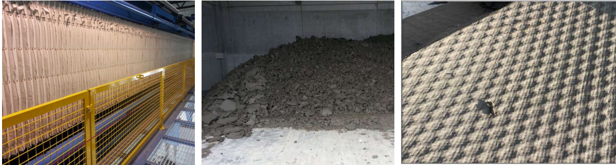
Figur 2-2 Bilder av filterpresse (venstre) og filterkake (midt, høyre) (Kilde: AF Decom)
