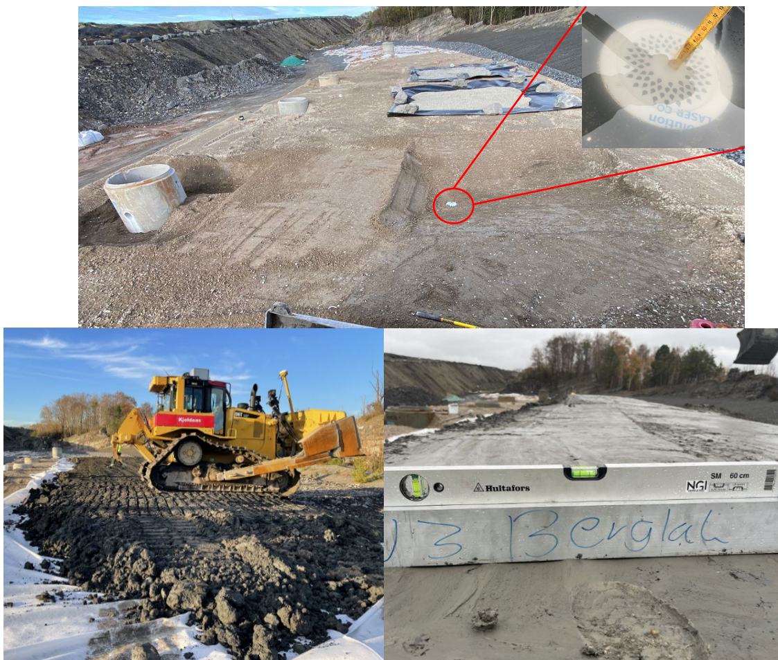
Figur 3-2 Bilder fra etablering av pilot på Langøya i 2022. Øverst: etablering av lysimeter. Det innrammede bilde i høyre hjørnet viser sluket i bunn ved kontroll etter at lysimeter (plastmembran) var lagt på plass. Et rør fører vann fra lysimeteret til betongkum med tipping bucket for måling av vannmengder. Nederst (venstre): Komprimering av første av tre lag. Nederst (høyre): Overflate av tettesjikt etter valsing av siste lag. (Foto: Ånes, 2022).
