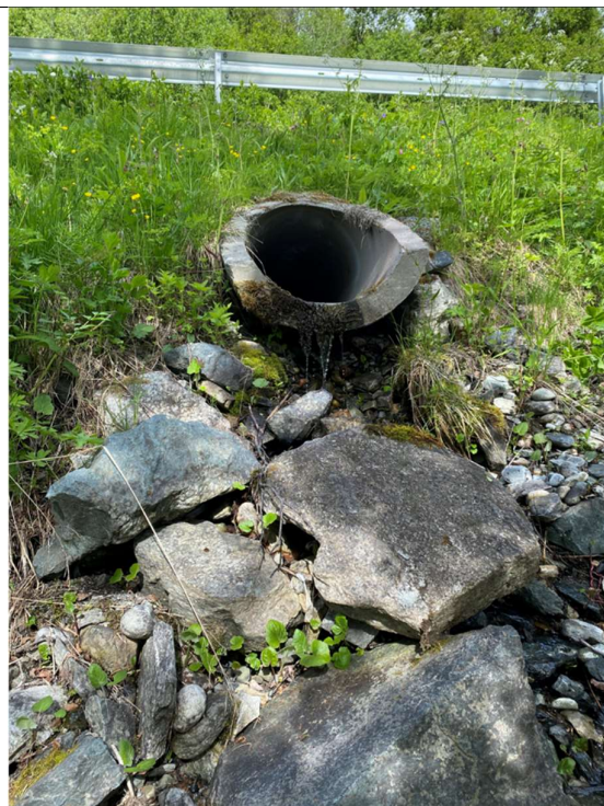
Bilde 2 Stikkledning 2 nedsiden av vegen.
