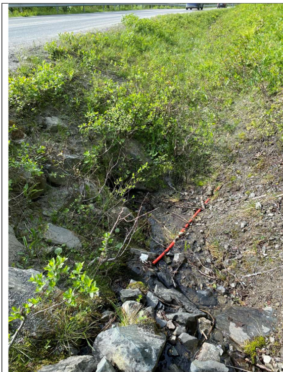
Bilde 1 stikkrenne 2 oversiden av vegen
