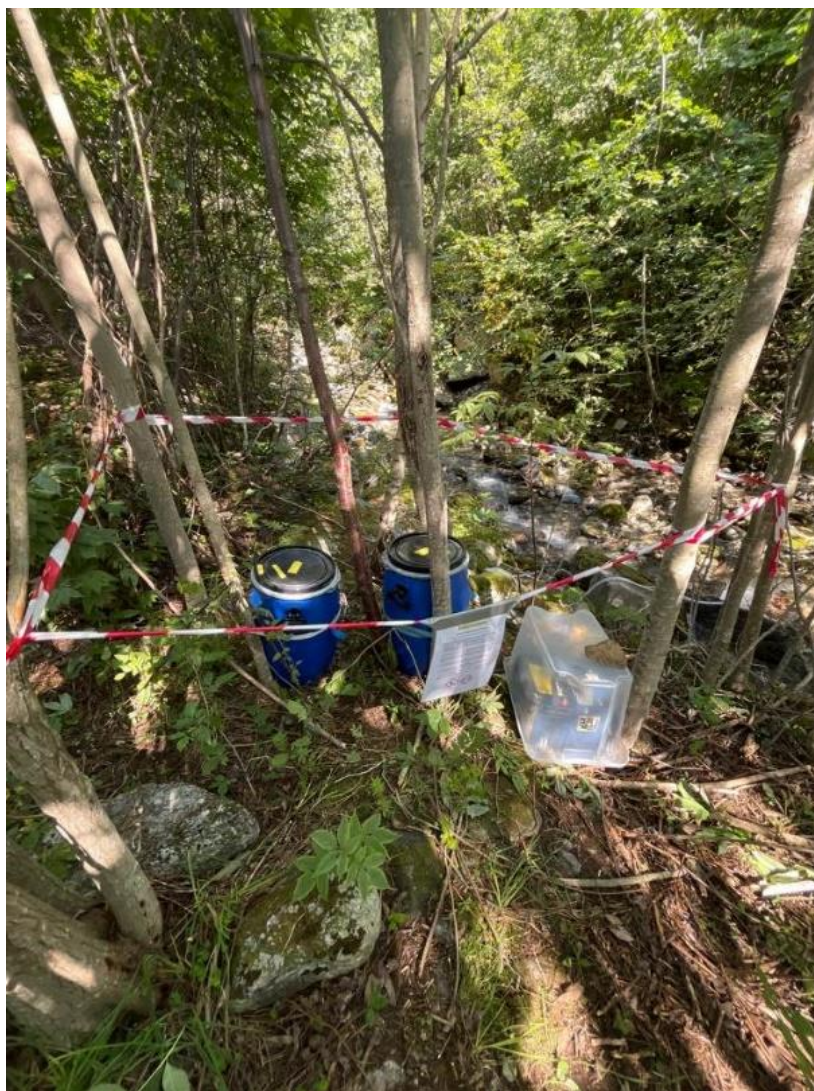
Figur 10. Ferdig rigget og startet blandestasjon i Fossa. Dette er toppdosereren i Fossa, hvor det ble brukt stor pumpe for innblanding av kjemikalier. Foto Enghild Steinkjer/NINA
