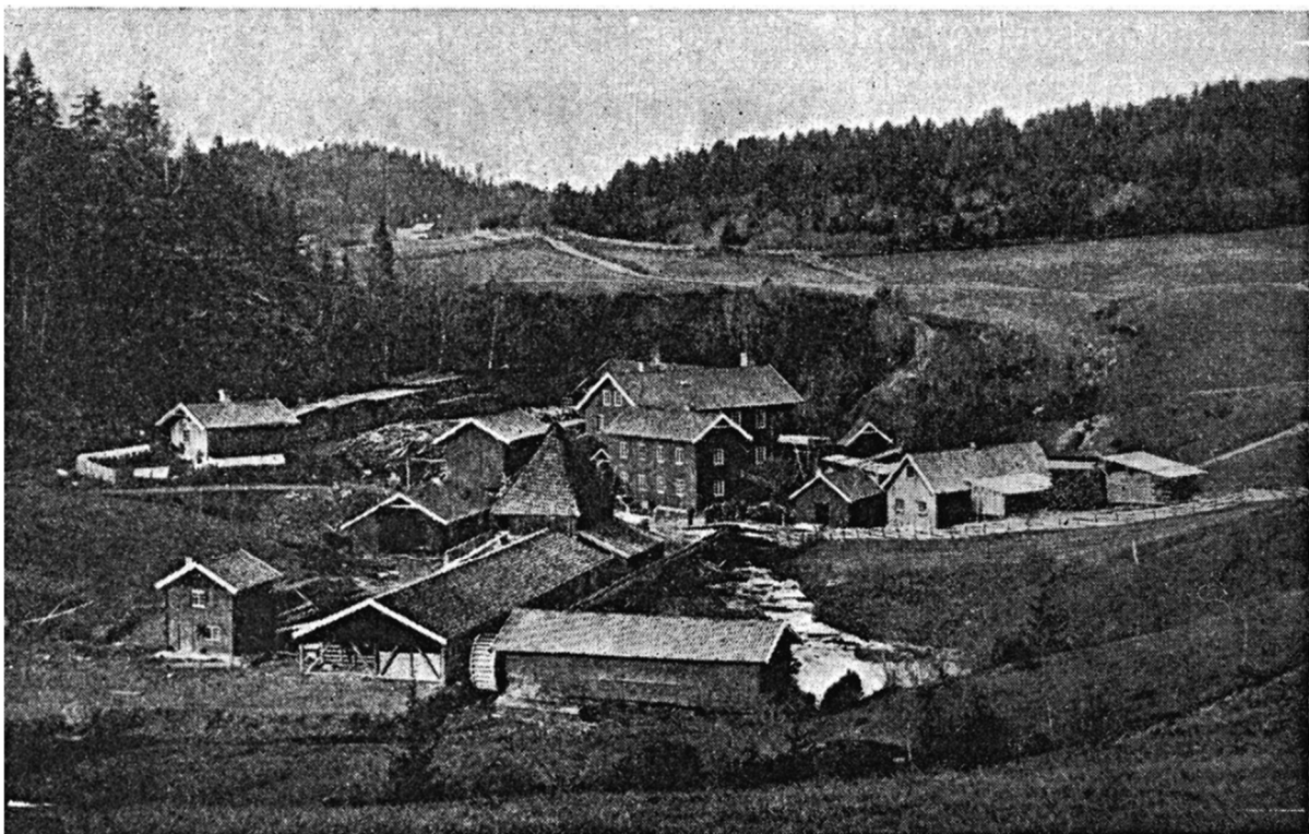
Jølsens første fabrikanlegg 1869. Foto: Norsk teknisk museum
