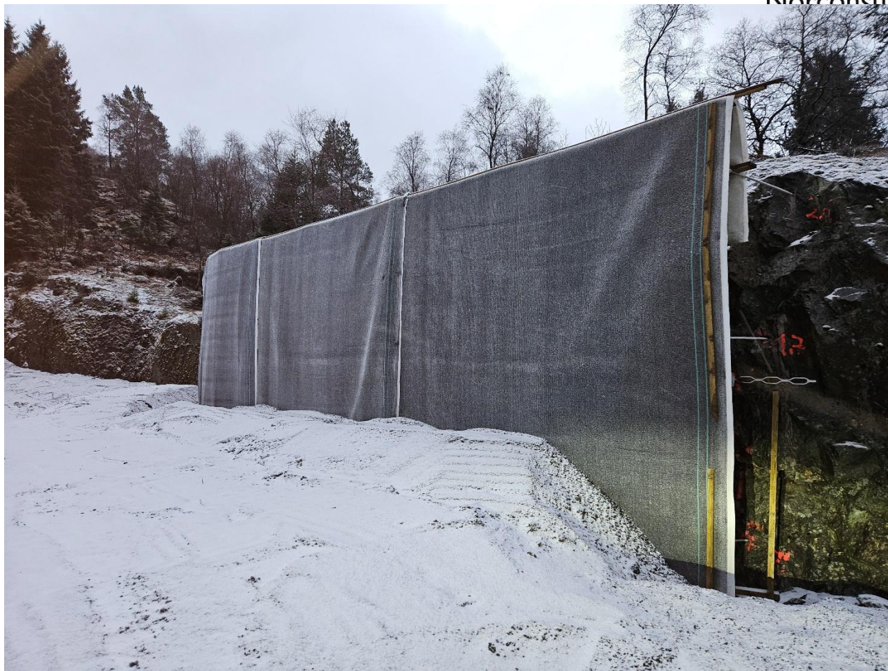
Figur 20 Vertikal sidetetting i eit pilotprosjekt på Mjelstad.
