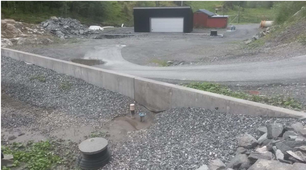
Figur 38: Under fangdam framfor eksisterande deponi er fjellgrunnen injisert for å tetta vassførande fjellsprekker i området.
