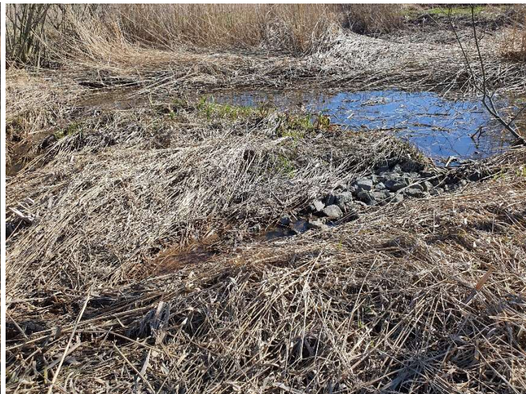
Terskel i fangdam ved utløp av Skirødbekken
