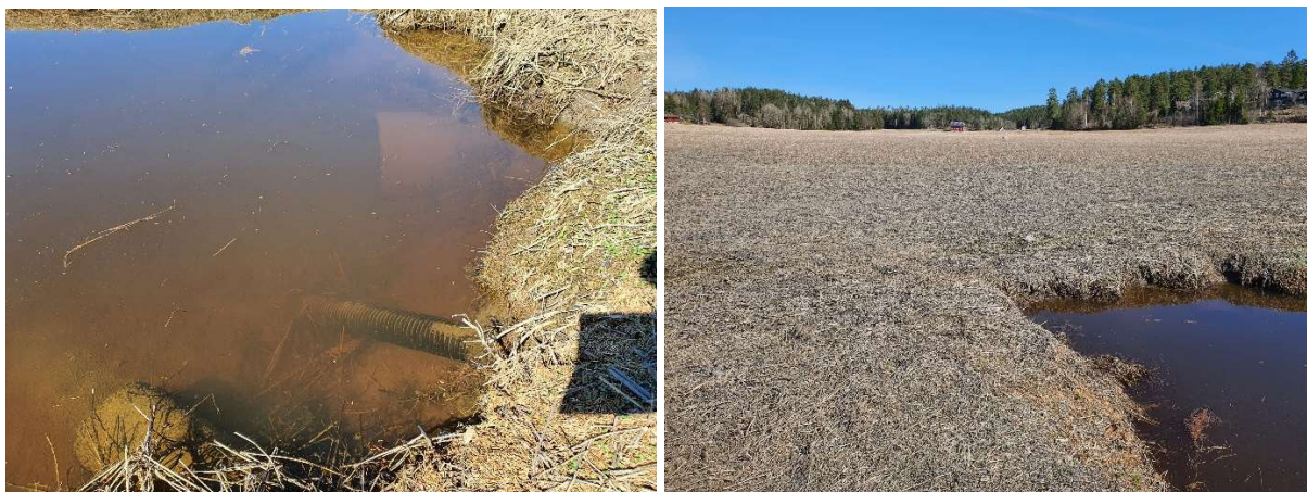
Dykkede utløpsrør og høy vannstand i Bjørnerødvannet
