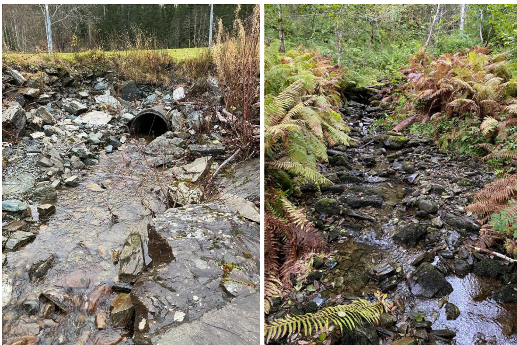
Figur 14. Midtigardsbekken ved utløpet til Snåsavatnet (venstre) og oppstrøms E6 (høyre).
