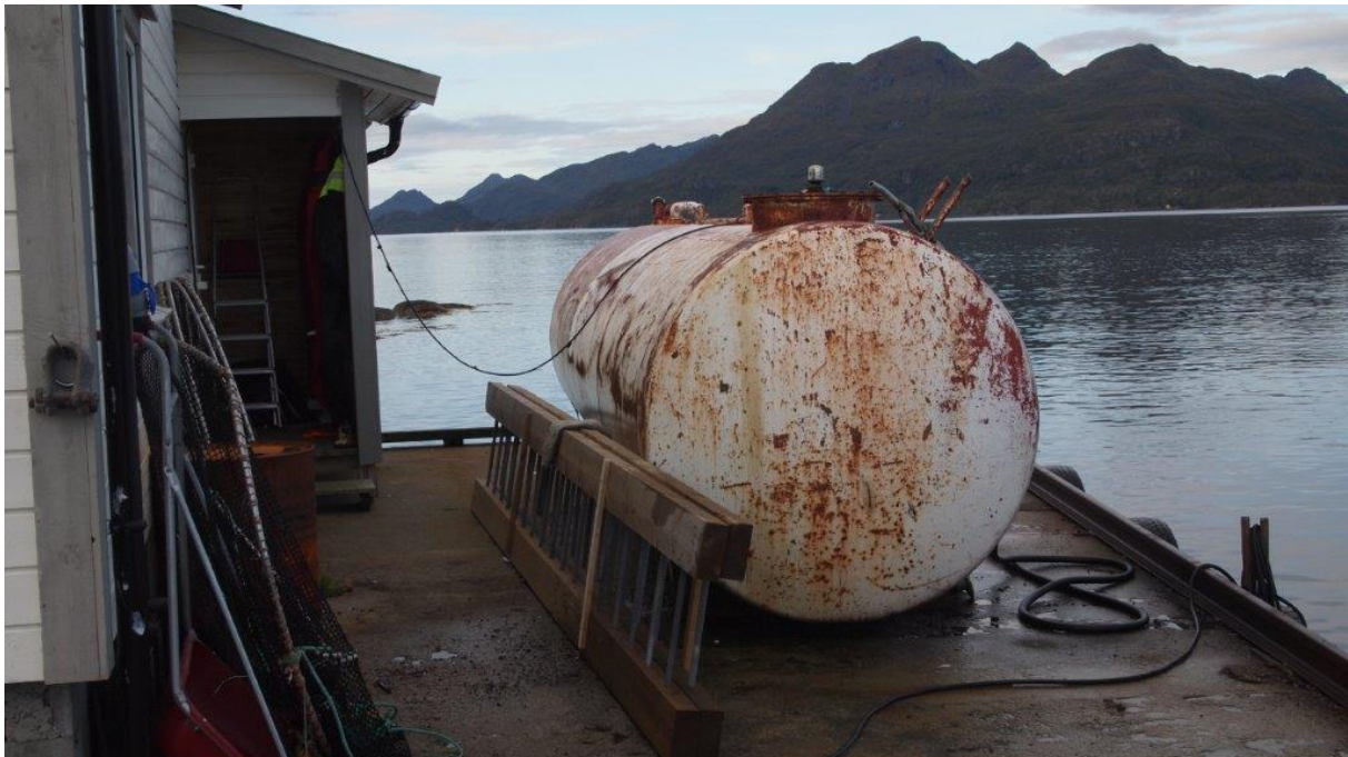
Figur 1. Dieseltank (11 m 3 ) på landbasen i Øksneshamn.
