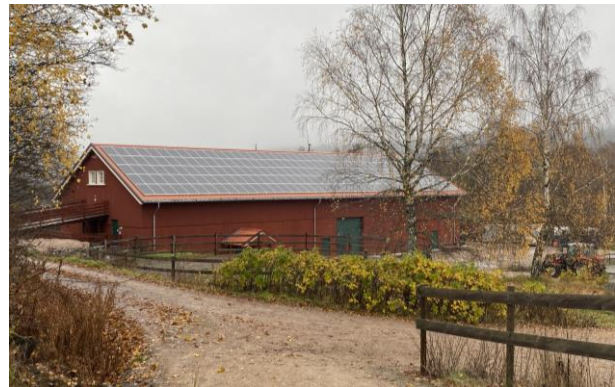
Figur 4. Solceller på låvetak på Rotnes bruk. Låven huser flisfyringsanlegget og flislageret. Foto: Statsforvalteren.
