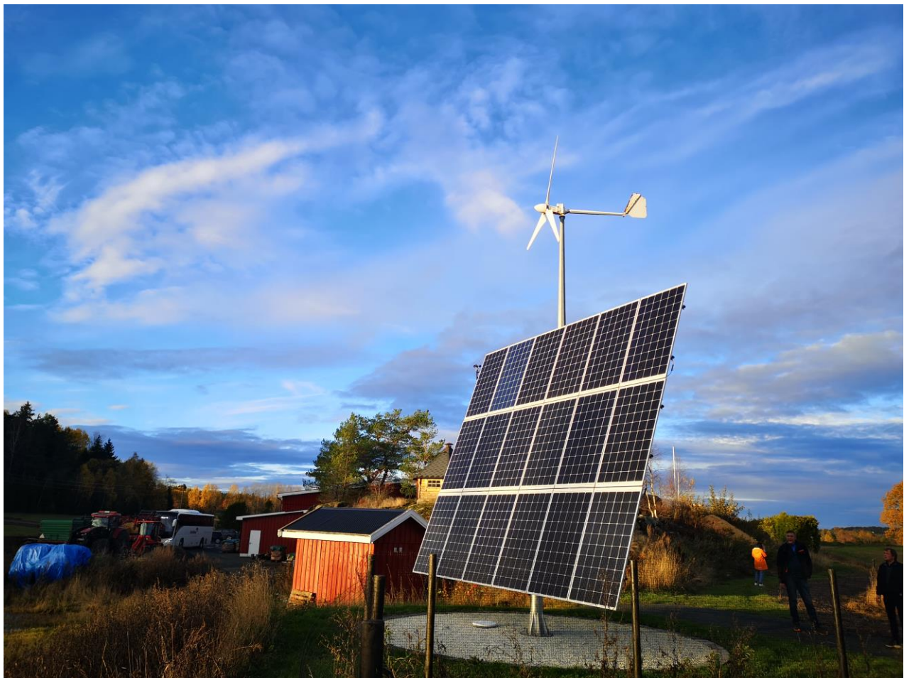
Figur 8. Roterende solfølgertårn kledd med solceller. I bakkant ses vindturbinen. Foto: Statsforvalteren.
