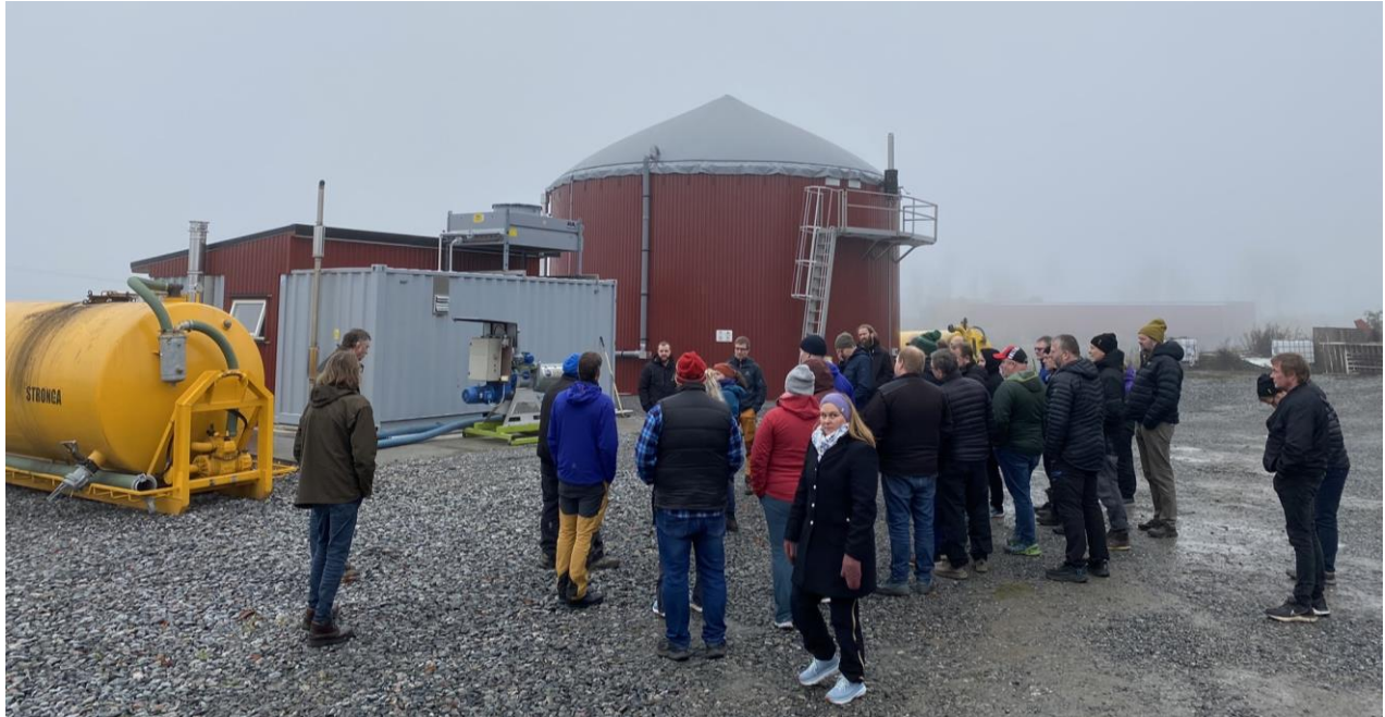
Figur 11. Biogassanlegget til Gunvor og Kjell Kopperud med reaktor, etterreaktor, strømgenerator og gjødselkum for biorest. Foto: Statsforvalteren.
