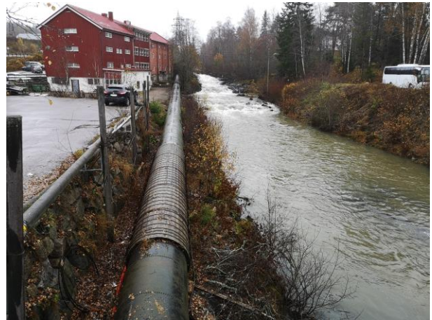
Figur 3. Nitelva og kraftproduksjon. Foto: Statsforvalteren.
