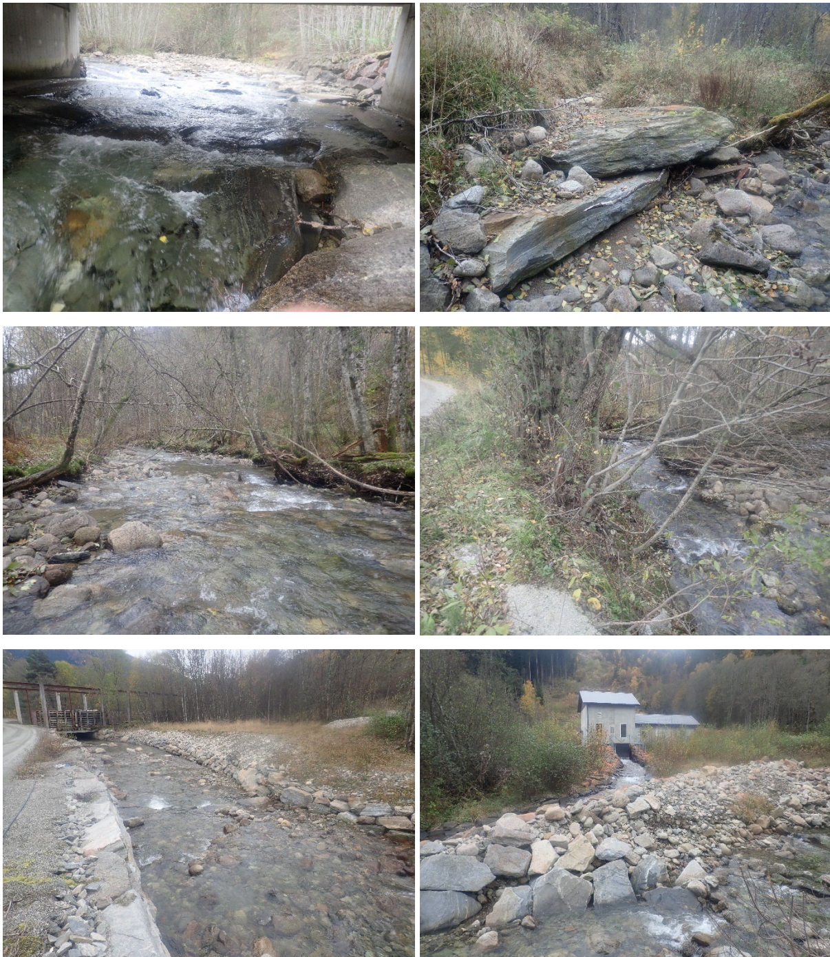
Figur 12. Øvre halvdel av Kvernelvi ved Høgamoen. Under veibroen er elvebunnen plastret (bilde øverst til venstre). Oppstrøm veibroen er det etablert en terskel og et tørrlagt sideløp er sperret av med store blokker (bilde øverst til høyre), trolig for å unngå for mye vann inn på flom. De to bildene i midten viser den naturtypiske strekningen mellom broene, mens de nederste bildene viser øvre del som er påvirket av terskler og erosjonssikring.
