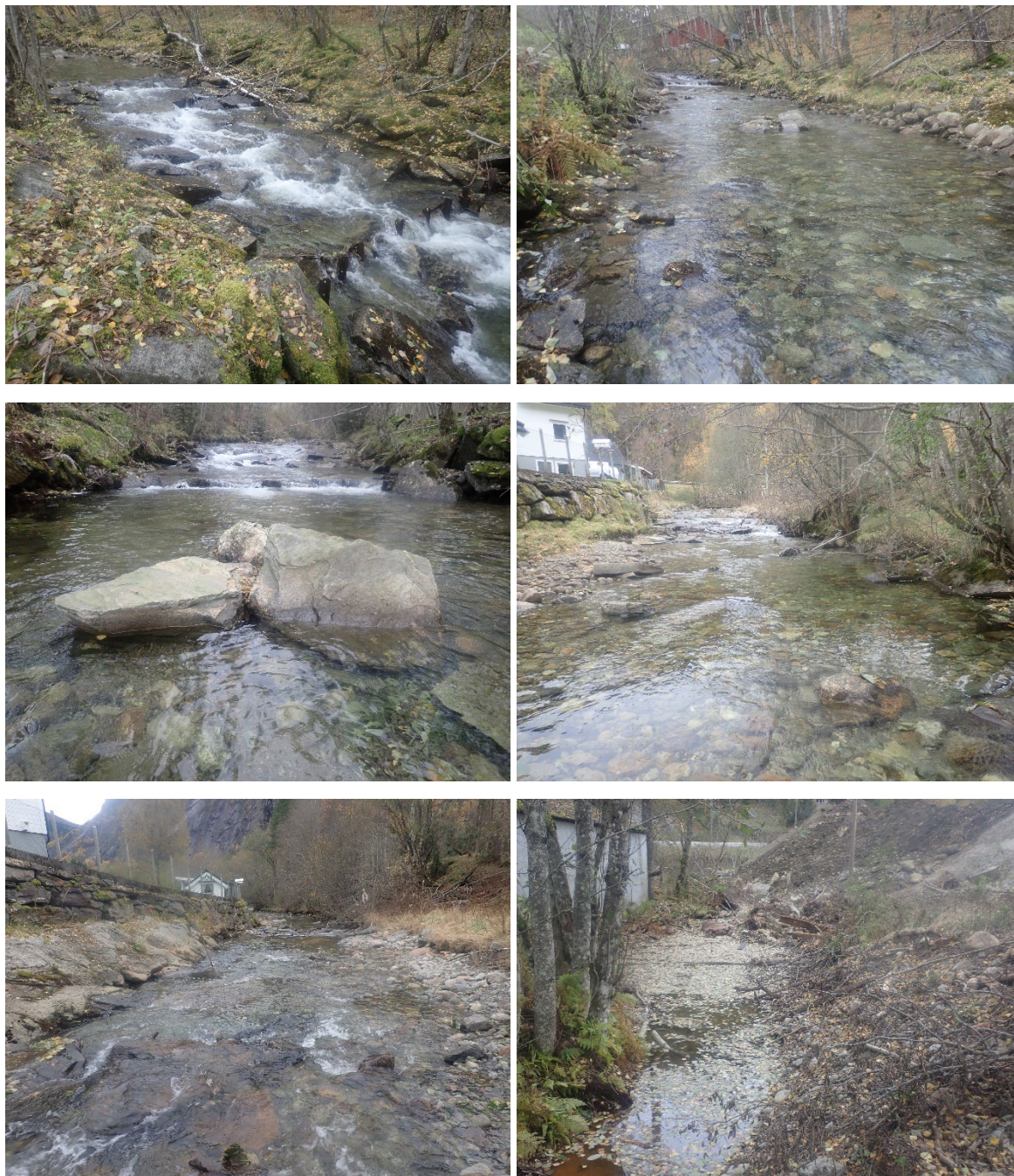
Figur 10. Det er etablert terskler, blokker og steinutlegg i nedre halvdel av Kverneelvi ved Høgamoen (De fire øverste bildene). Nederst i elva er den ene siden forbygd, og elva er delvis plastret (bilde nederst til venstre). Det kom ut urent misfarget vann fra en pågående utfylling langs elven (bilde nederst til høyre).
