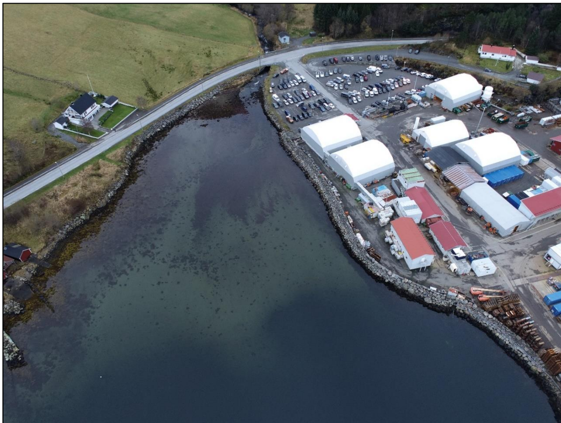
Figur 4. Dronebilde av Myklebustosen tatt 06.11.2024, som viser sjøbunnen i området som skal fylles ut. Merk at fyllingen til høyre i bildet ble utvidet i 2025 etter at dette bildet ble tatt (se Figur 2 ).
