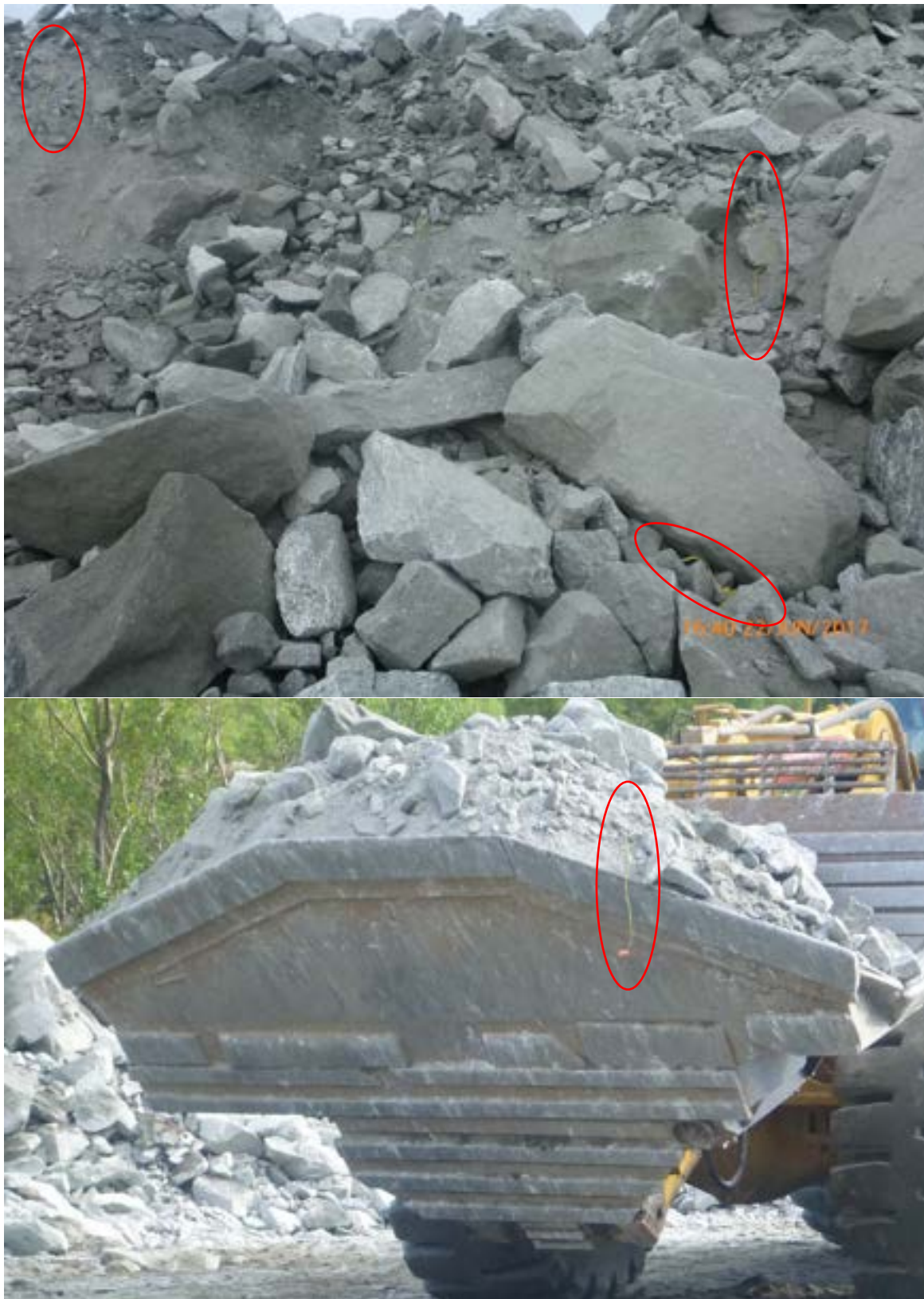
Figur 7: Rester av skyteledning i tunnelmasser
