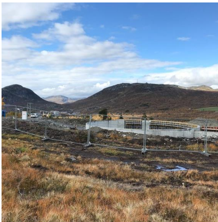
Vannverk bygges på myr i forbindelse med nytt hyttefelt
