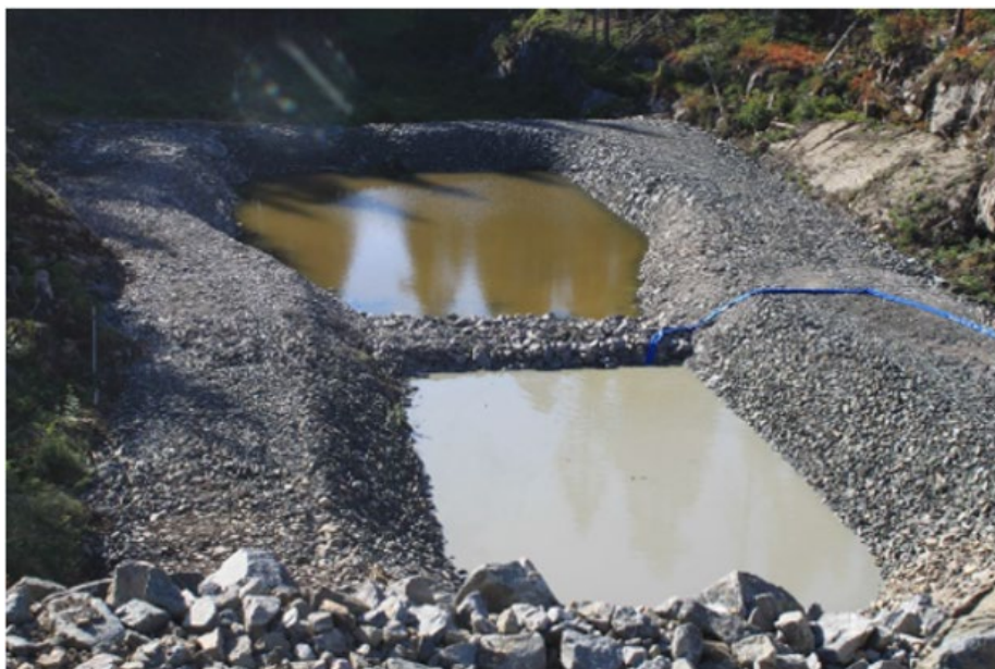
Figur 9: Eksempel på sedimentasjonsbasseng nedstrøms massedeponi.
