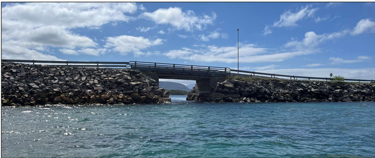
Figur 3 Terøybrua sett mot sør.
