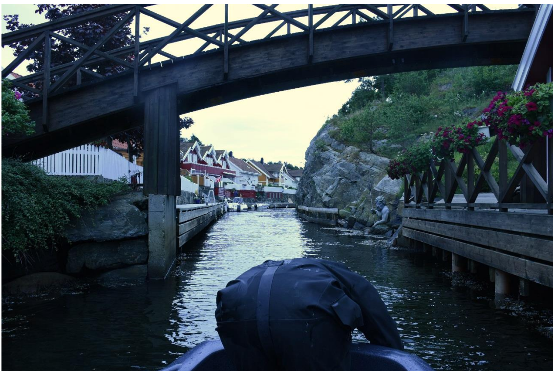
Figur 14 Befaring med vannkikkert i den kunstige delen av kanalen Foto Sweco AS
