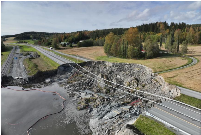
Figur 9: Raset ved Nesvatnet i Levanger kommune i 2025. Foto: Bane Nor
