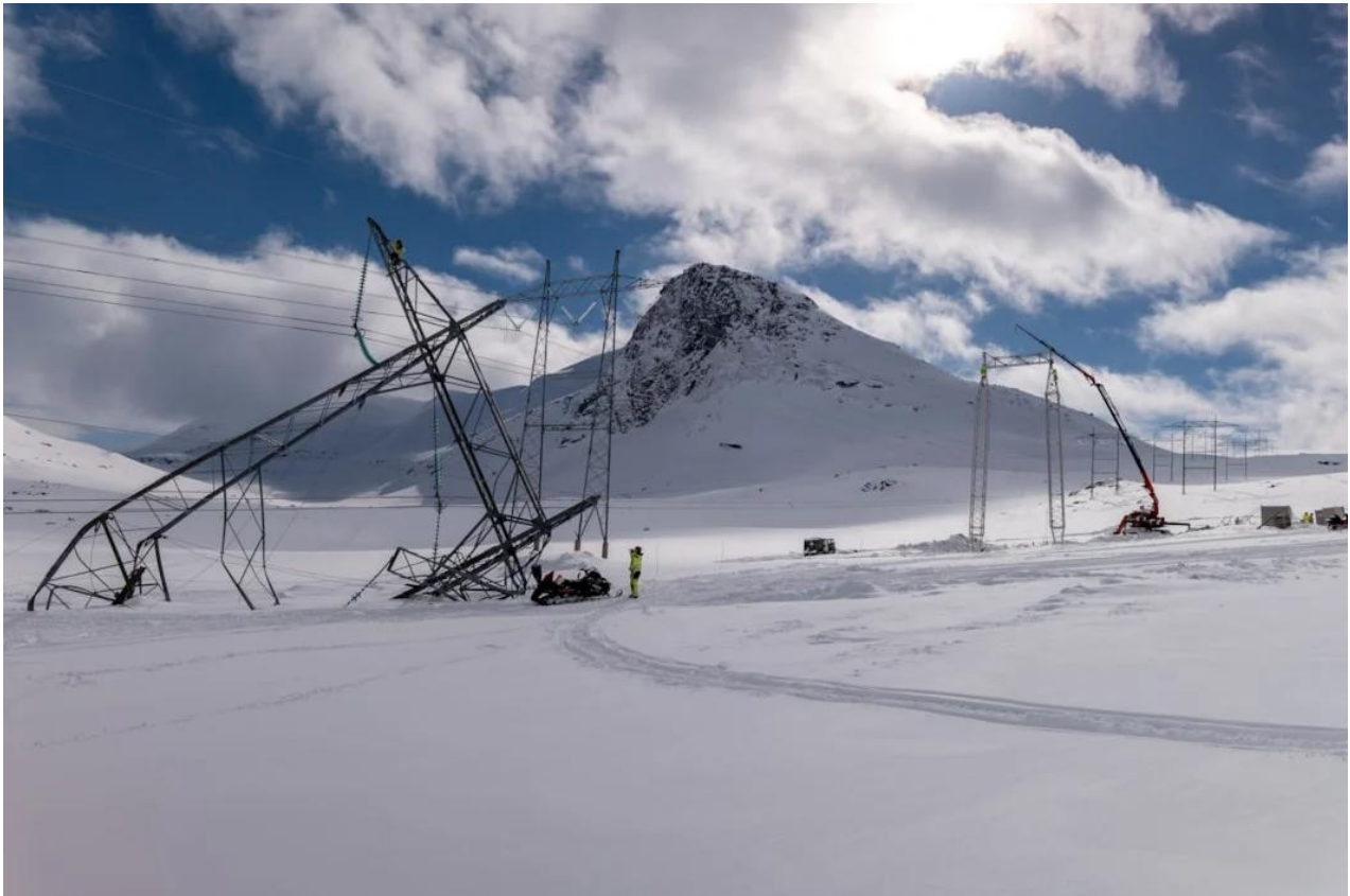
Figur 13: Havarert mast og beredskapsmast i bakgrunnen i Skamdalen, Narvik kommune i mars 2025. Foto: Statnett.
