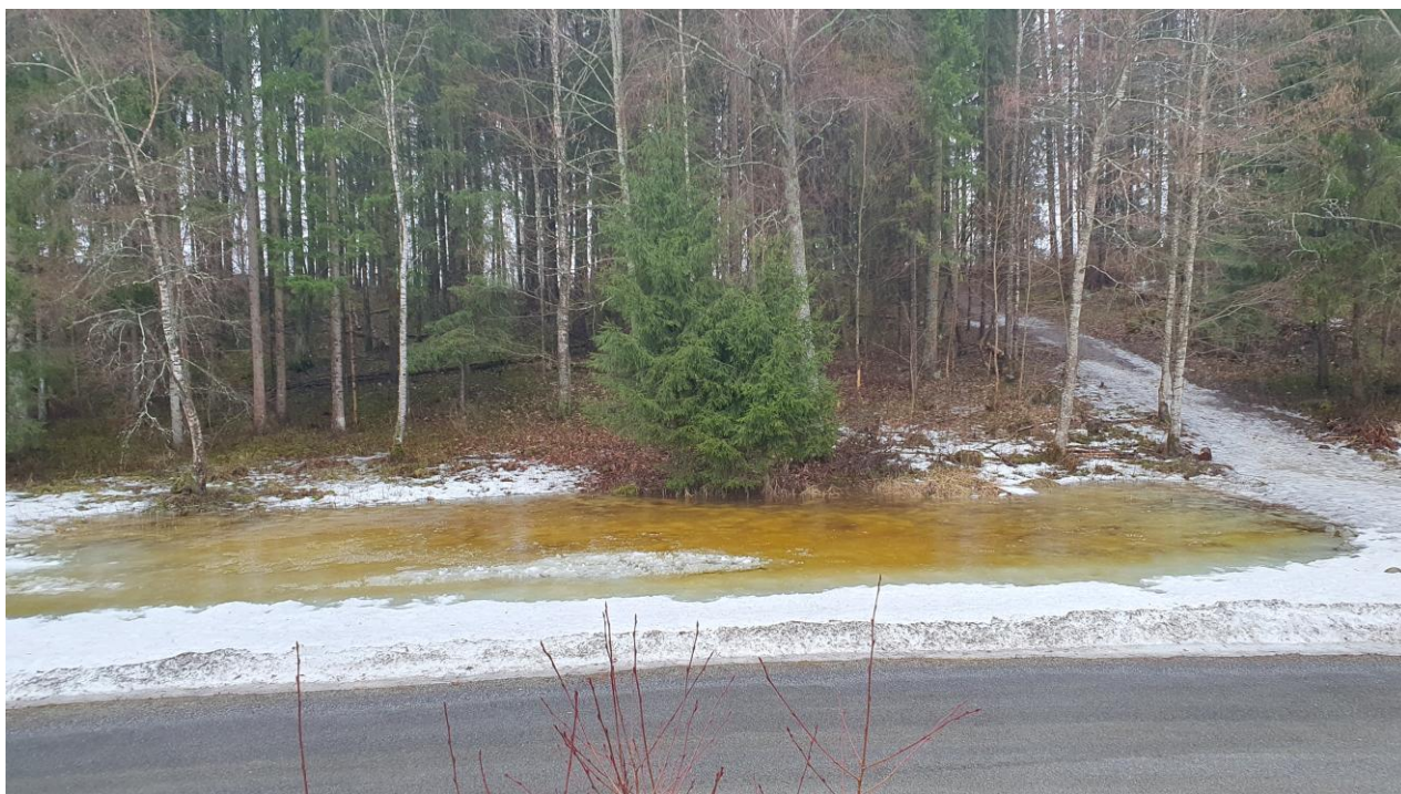
Figur 10: Snøsmelting og overvannsproblematikk. Fotograf: Sigrid Johanne Langsjøvd, NVE.
