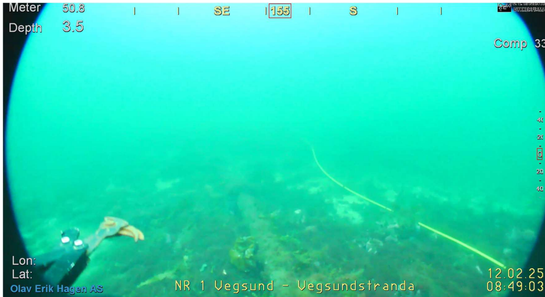
Figur 12 Stillbilde fra ROV video. Dagens rørledning midt i bilde, brunalger og sand-/grusbunn rundt.
