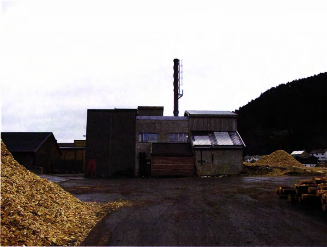
Figur 2.27 Bygg med biobrenselanlegg
