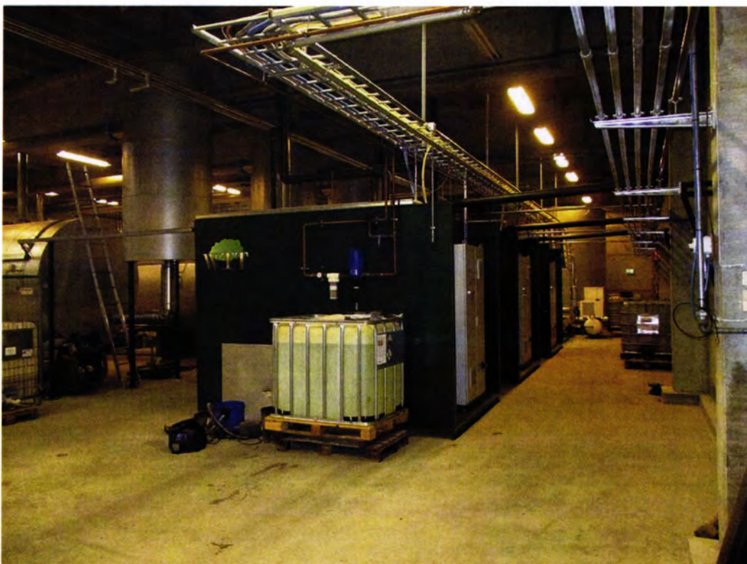
Figur 2.18: Ny royallinje, en ser betongkanten på gulvet til høyre i lokalet
