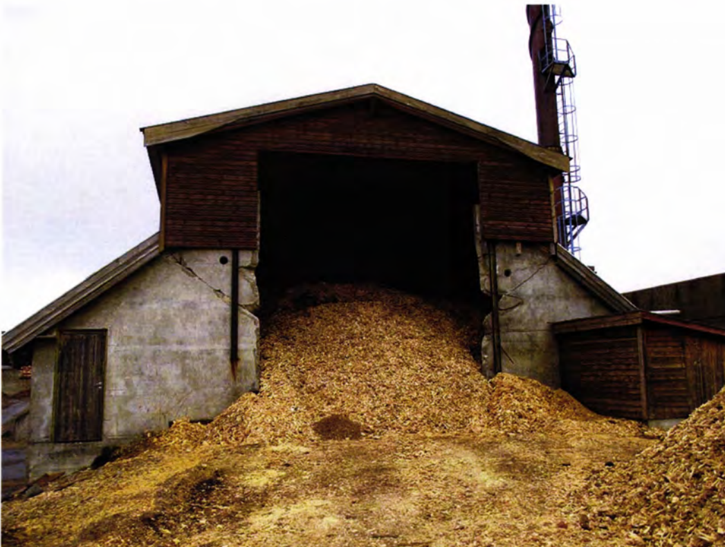
Figur 2.26: Tømmelomme for flis til biobrenselanlegget
