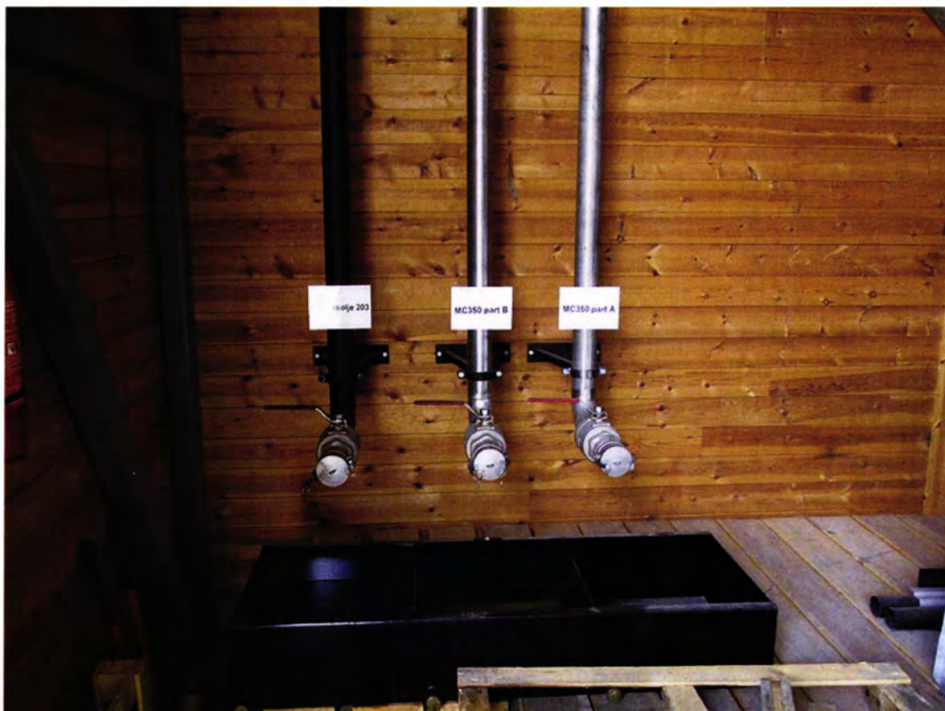
Figur 2.11: Stusser for tilkobling av fylleslanger for impregneringsvæsker i ny royallinje – Merking i samsvar med forurensningsforskriften §18-4 (se Prosedyre "fylling av lagringstanker" 425.9a).
