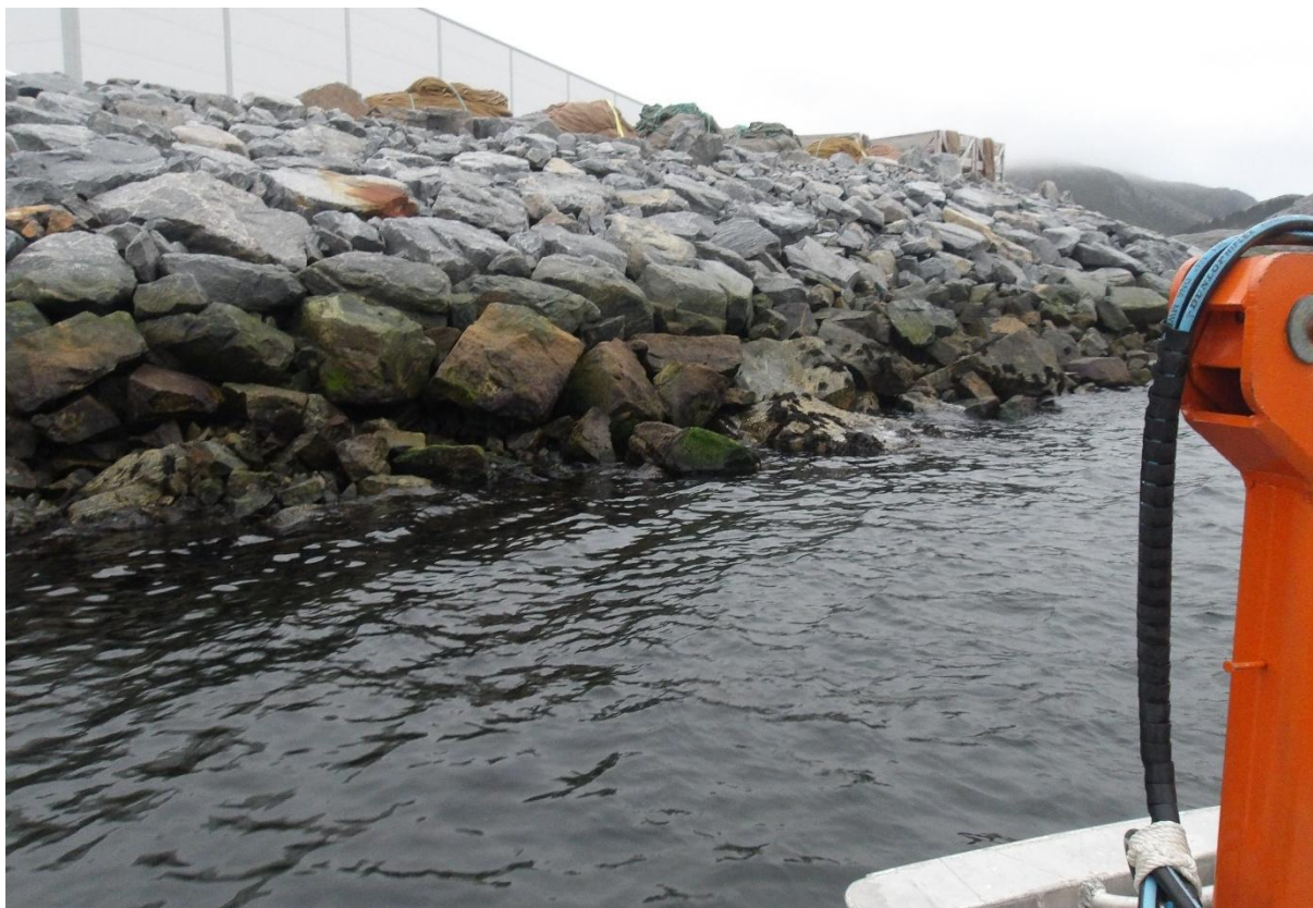
Figur 3.2: Oversikt over undersøkelsesområdet med den eksisterende fyllingsfronten.
