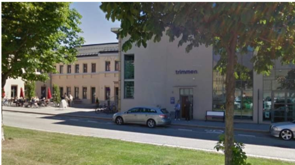
Markering av adkomst ved bruk av mye glass og aktivisering av 1.etasje mot Erik Børresens allé. Det offentlige rommet trekkes delvis inn i kvartalet. Denne situasjonen blir uendret som følge av planforslaget.
