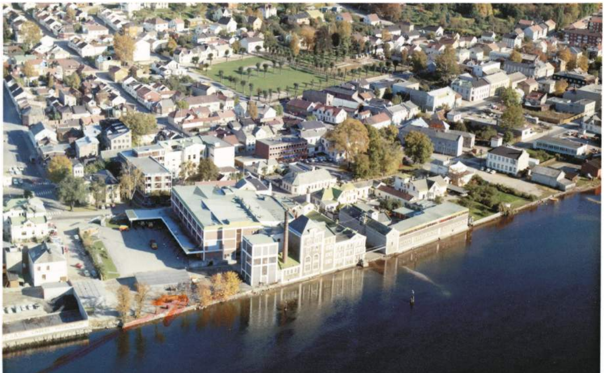
Flyfoto som viser Drammen i 1968 (Drammen byarkiv). Aass bryggeri ligger fortsatt helt ut i vannkanten. Deler av fasaden mot elva kjenner vi igjen i dag.
