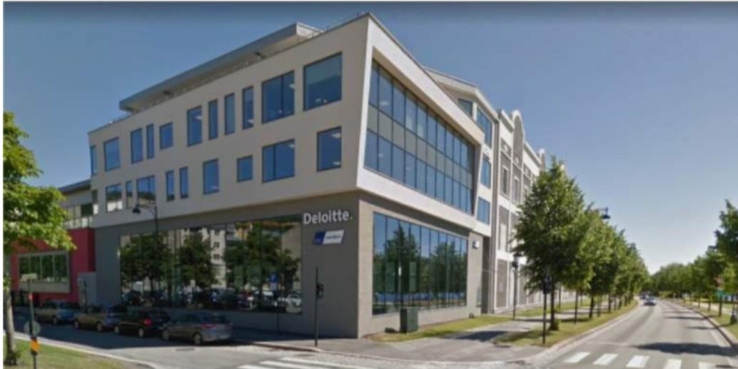
Store glassfelt bidrar til å offentliggjøre driften som foregår på innsiden, og gir et fint liv til gaterommet. Det offentlige får på denne måten delvis ta del i virksomhetens drift.
