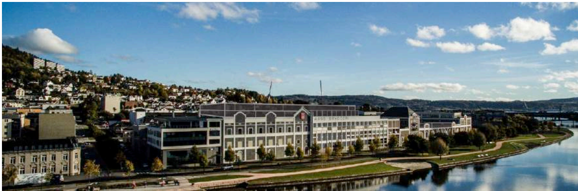
Foto Aass Bryggeri sett fra sydvest. De planlagte påbyggene vil bli synlige fra avstand, men fordi påbygget Strandveien 9 vil ligge tilbaketrasket, vil den særpregede fasaden som kjennetegner bedriften i dag, fortsatt være dominerende.
