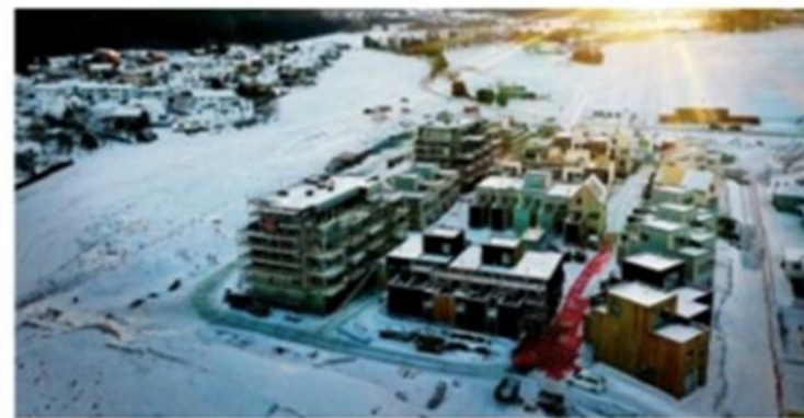
Bygging på Overvik er i full gang. Tirsdag stanset politikerne et nytt byggetrinn til venstre for husene på bildet inntil videre.
