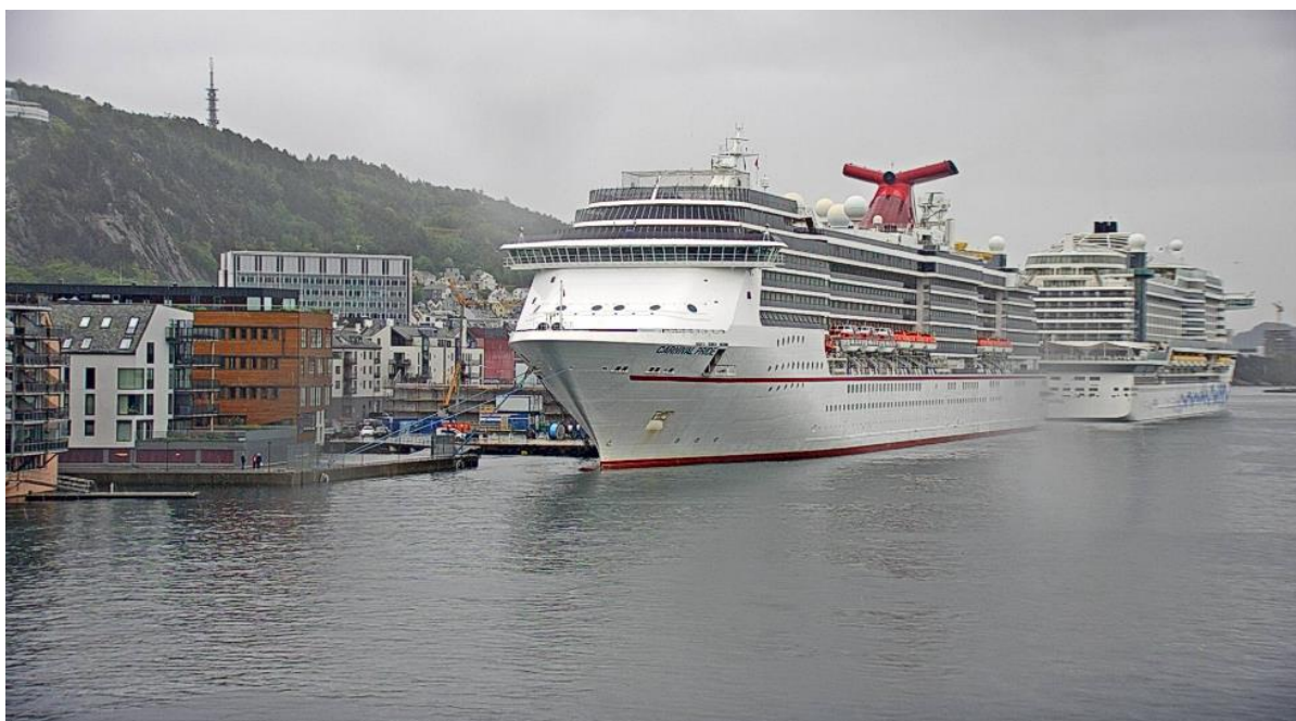
Figur 19. Bilde av Prestebrygga og Storneskaia 14. juni 2022 hentet fra Ålesund Havn sine hjemmesider (Ålesund Havn, 2022).
