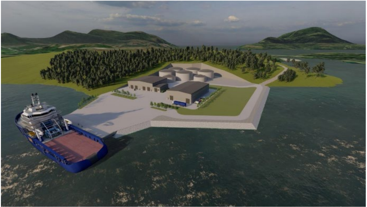
Figur 6 Illustrasjon av anlegget sett fra nord.
