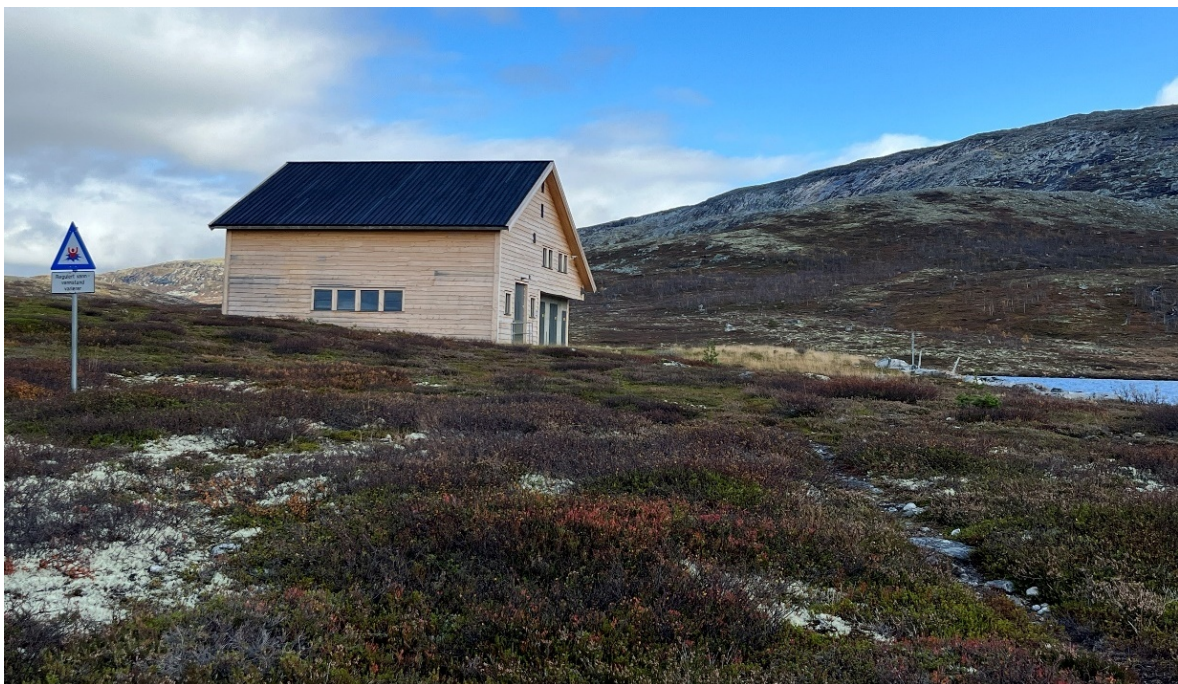
Figur 3 Pumpestasjonen på Viervatn har nyleg gjennomgått eit større vedlikehaldsarbeid. Bygget med pumpestasjonen, demninga og vatnet ligg inne i naturreservatet. Foto: Statsforvaltaren i Vestland/ Maria Knagenhjelm.
