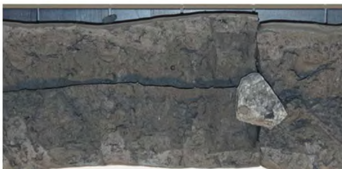
Figur 7: Bilde fra prøveåpning av BH.13, dybde 3,2-4,0 m. Massene er siltig, sandig, leirig materiale med gruskorn.
